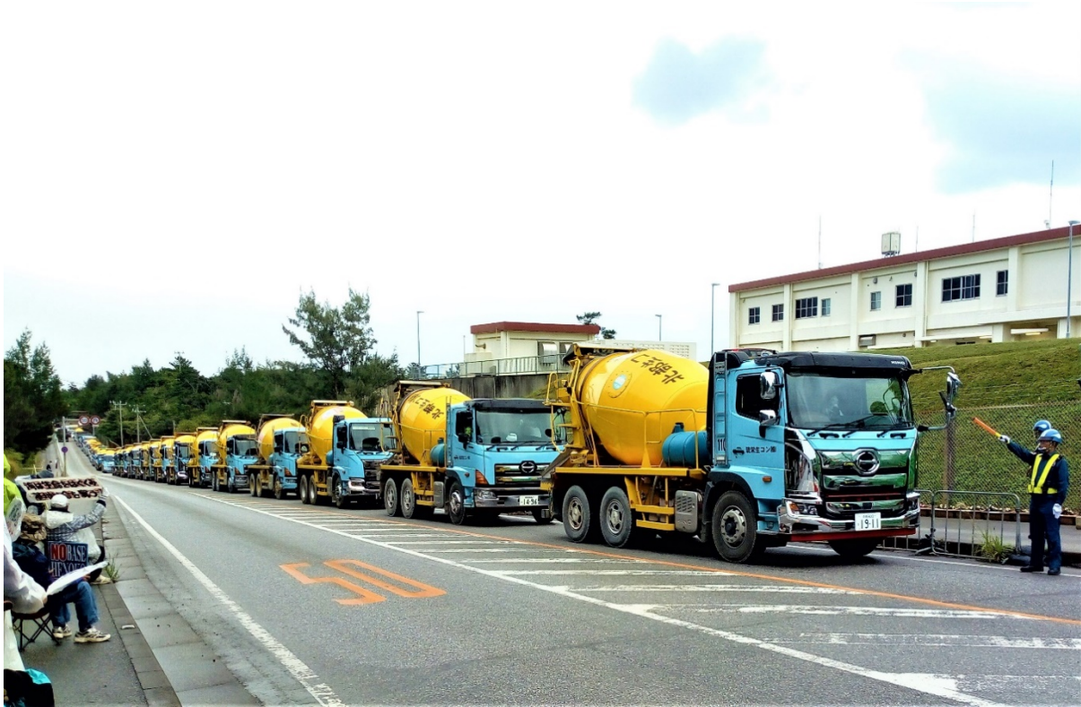
Figura 4. Una lunga fila di camion betoniera si accumula sulla strada adiacente al cantiere, in attesa della conclusione del picchetto degli attivisti e di poter accedere per depositare il materiale. La fotografia rende l'idea della quantità di materiale necessaria per la realizzazione del progetto di costruzione. Foto di Andrea Apollonio, 16/12/2020
