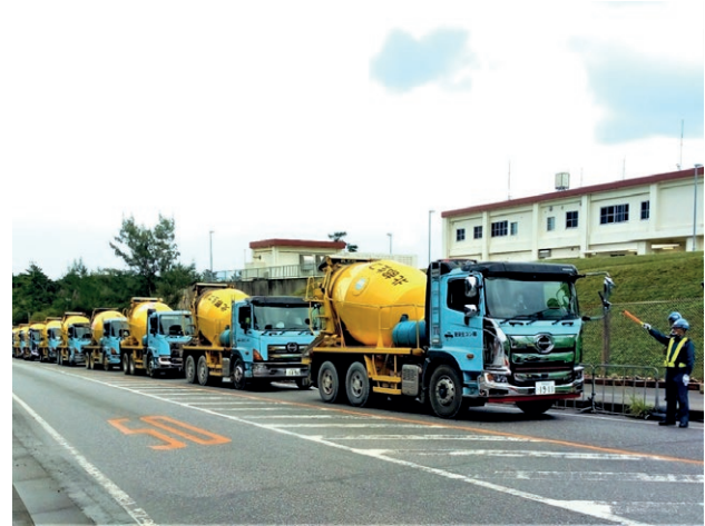
Fig. 4. Una lunga fila di camion betoniera si accumula sulla strada adiacente al cantiere, in attesa della conclusione del picchetto degli attivisti e di poter accedere per depositare il materiale. La fotografia rende l'idea della quantità di materiale necessaria per la realizzazione del progetto di costruzione. Foto di Andrea Apollonio, 16/12/2020.
