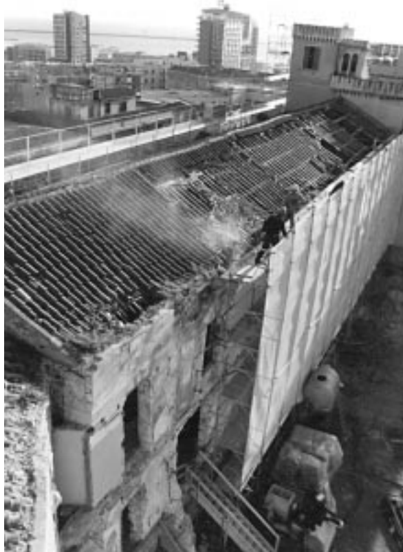
Figura 4 – Fronte interno: tetto e torrino a valle ante lavori.
