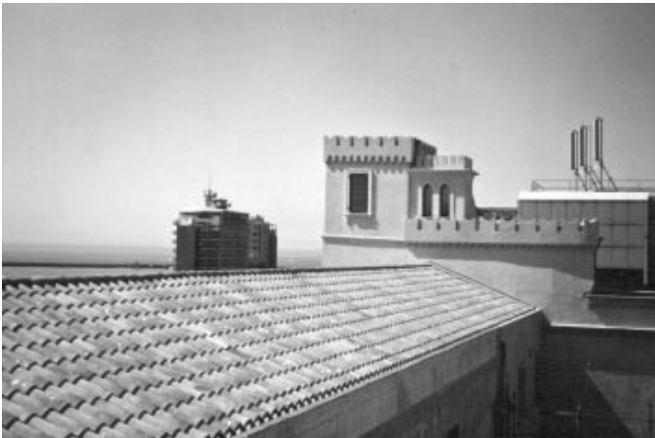
Figura 5 – Fronte interno: tetto e torrino a valle post lavori.
