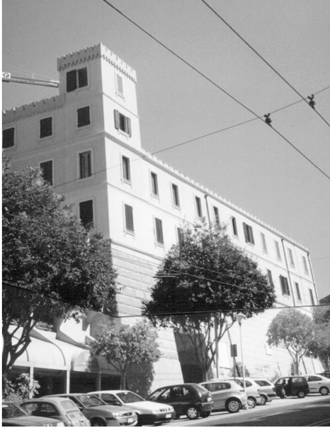
Figura 3 – Facciate risanate post lavori.
