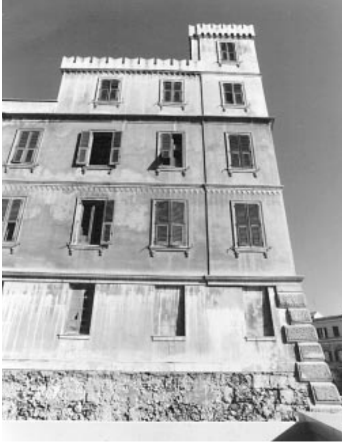
Figura 2 – Dettaglio facciata ante lavori.
