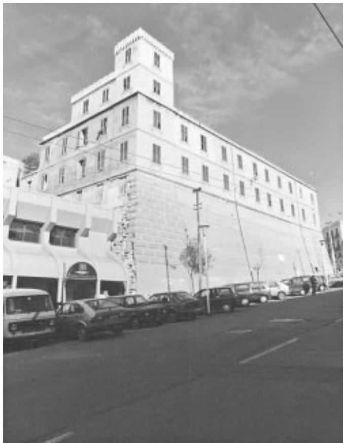
Figura 1 – Vista del corpo sul v.le Regina Margherita 8 ante lavori.
