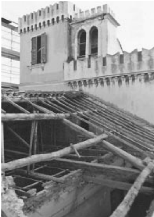
Figura 6 – Dettaglio orditure tetto con torrino ante lavori.
