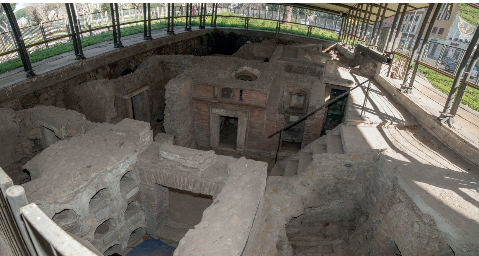
Fig. 1 Roma, Sepolcreto della via Ostiense: visione degli edifici sepolcrali da sud-est Foto A.R. Rubino, C. Santan- gelo, © ICR.
