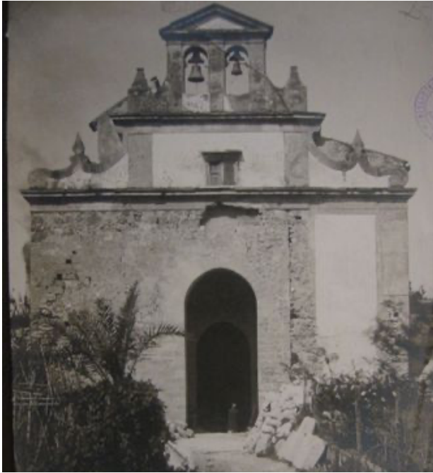
Fig. 4 Palermo, chiesa di S. Giovanni dei Lebbrosi, facciata prima dei restauri (CARMEN GENOVESE, op. cit., p. 68).
