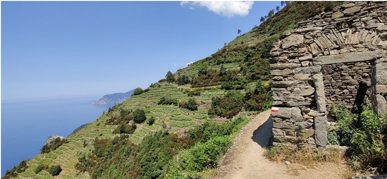
Fig. 2 Cinque Terre, Liguria (IT), terrazzamenti e ruderi di un manufatto rurale costruito con tecnica dei muri a secco (Marchese 2022)
