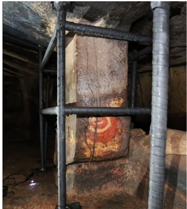
Fig 4 Bonorva (SS), Necropoli di Sa Pala Larga, Tomba n.7 - Pilastro centrale con i puntelli provvisori
