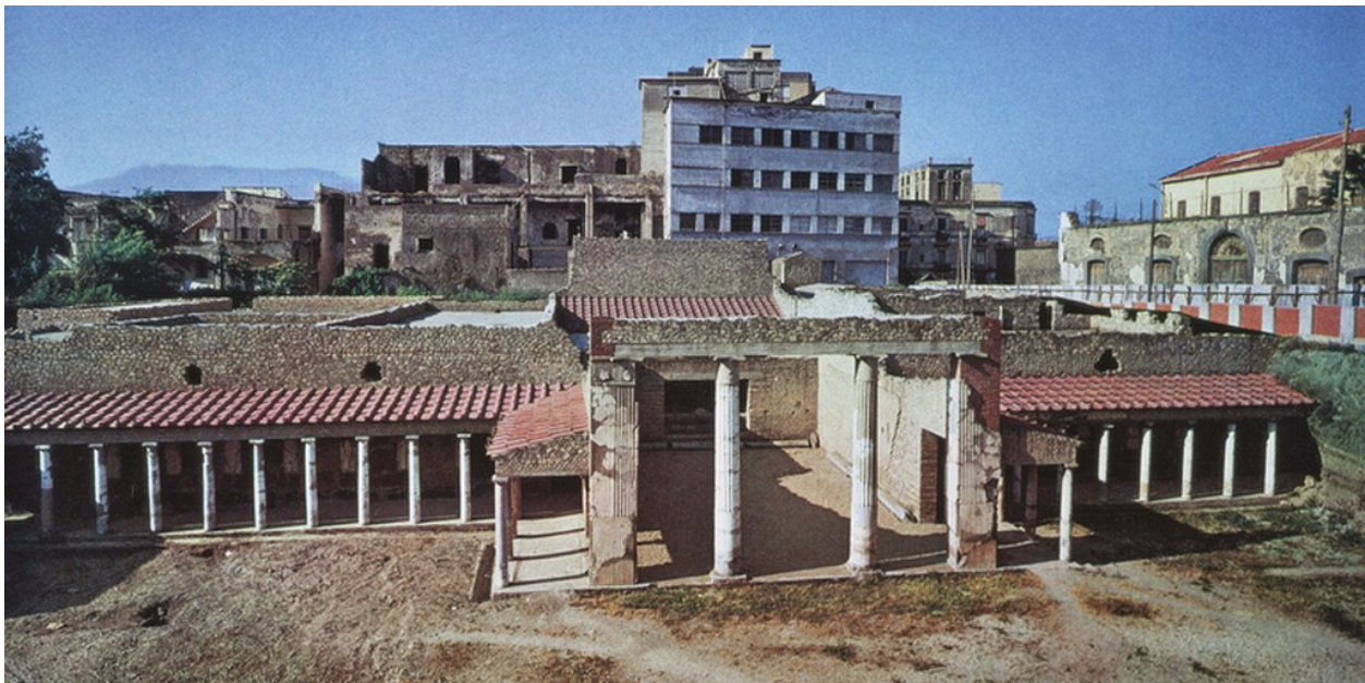
Fig. 4 Gli interventi di restauro e ricomposizione degli elevati e delle coperture degli anni '80 (University of California, San Diego, Retrieved from https://library.artstor.org/asset/ARTSTOR_103_41822003506829 )
