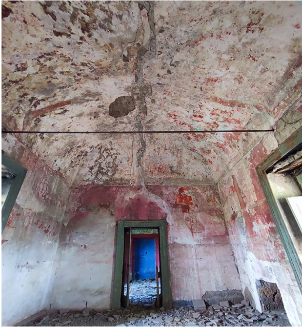
Fig. 5 Casina Spinelli, Acerra. Stanza avente la copertura con volta a padiglione decorate in parte dal colore rosso pompeiano.
