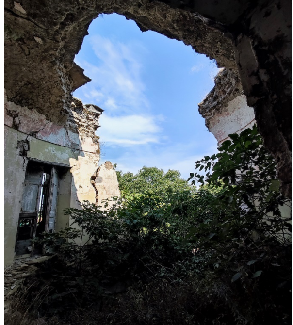
Fig. 6 Casina Spinelli, Acerra. Resti della stanza a forma ellittica.
