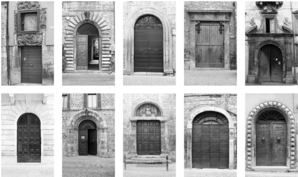
Fig. 3 Esempi delle tipologie di portali presenti nel centro storico. Le informazioni su ubicazione, tipologia e periodo storico di costruzione sono organizzate all'interno del database (foto C. Vagozzi)
