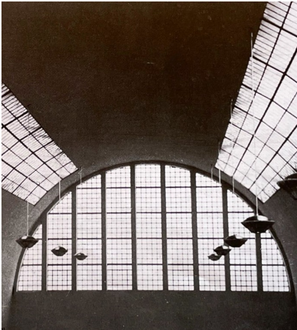
Fig. 2 P. Belfiore, Vista interna della volta a botte originaria del mercato ittico di Napoli in una fotografia storica, 2006
