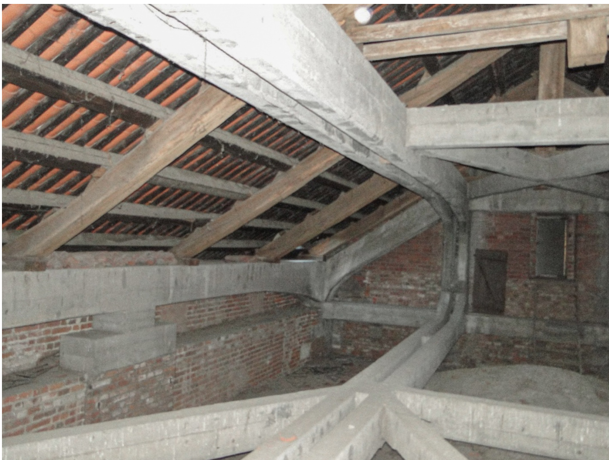
Fig. 6 Vercelli, Basilica di S. Andrea, consolidamento della copertura progettato dall'ingegnere Antonio Giberti nel 1927 (foto P. Faccio, 2019).
