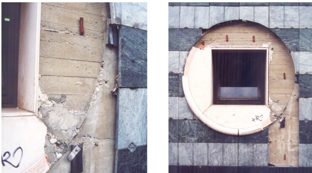
Fig. 5 Firenze, Terminal via Valfonda, particolare di un'apertura con i distacchi del rivestimento (foto P. Matracchi 2004).
