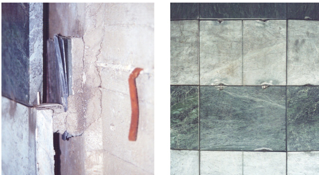
Fig. 6 Firenze, Terminal via Valfonda, il degrado del rivestimento ha messo in luce il sistema di ancoraggio alla parete in calcestruzzo (foto P. Matracchi 2004).
