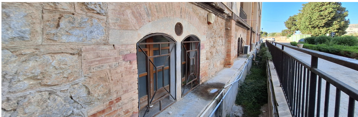
Fig. 3 Palermo, ex Sanatorio Cervello ai Petrazzi, fascia basamentale con bifore in c.a. e laterizio del 'padiglione gestanti' dell'ing. Nicolò Milazzo Cervello (foto F. Giuffrè, 2025).
