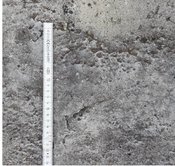
Fig. 2 Dettaglio dei disallineamenti dei casseri che hanno prodotto dei dentelli (© Supsi, 5 settembre 2023).
