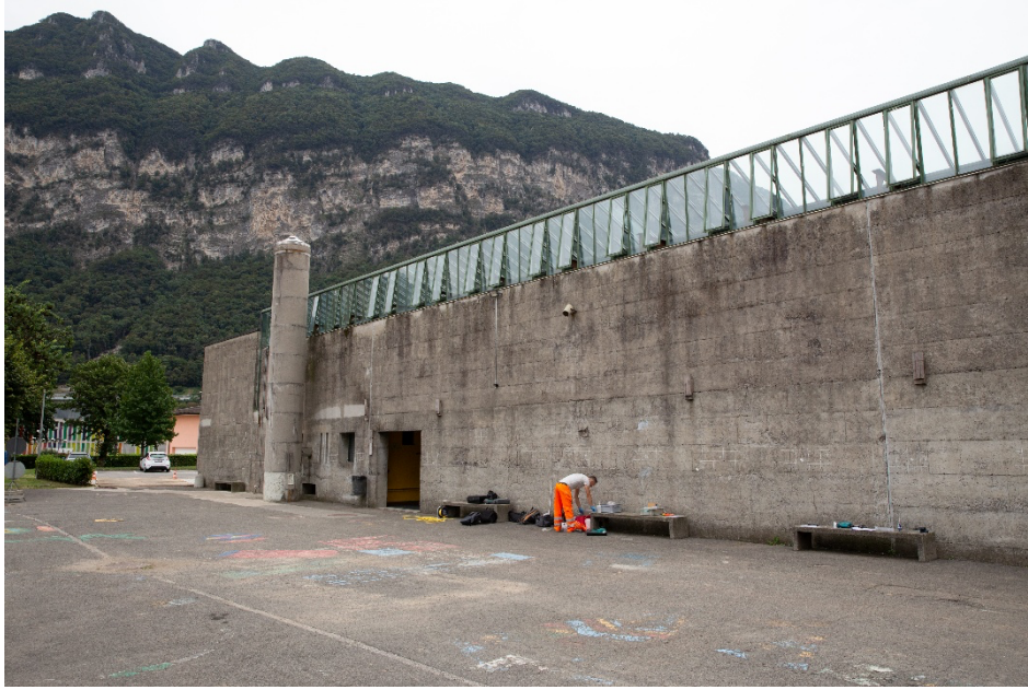
Fig. 1 Facciata Nord della Palestra (© Supsi, 5 settembre 2023).
