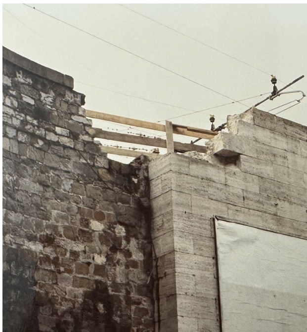
Fig. 6 La spalla del sovrappasso di viale Strozzi realizzato negli anni Trenta del Novecento durante i lavori di realizzazione del nuovo ingresso alla Stazione di Santa Maria Novella, 1989 (Foto ©Impresa Gioacchino Minuto, S.r.l.).
