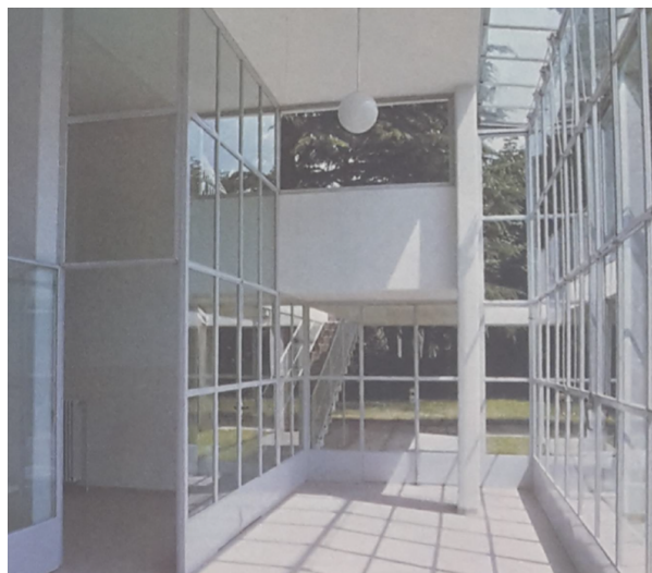
Fig. 6 Como, Asilo Sant'Elia, una delle aule dell'asilo: sono visibili i serramenti sostituiti negli anni '60, in ALFREDO SALA, Il razionale e i suoi dettagli. Frugando tra i particolari costruttivi dell'asilo Sant'Elia e del Novocomum di Terragni , «Modo», a. IV, n. 26, gennaio-febbraio 1980, p.27.
