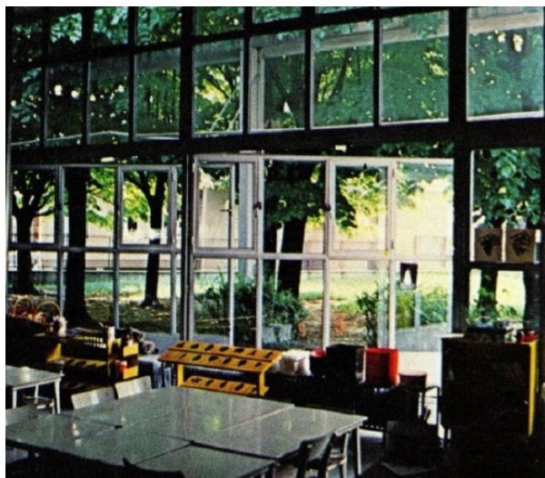
Fig. 6 Como, Asilo Sant'Elia, una delle aule dell'asilo: sono visibili i serramenti sostituiti negli anni '60, in ALFREDO SALA, Il razionale e i suoi dettagli. Frugando tra i particolari costruttivi dell'asilo Sant'Elia e del Novocomum di Terragni , «Modo», a. IV, n. 26, gennaio-febbraio 1980, p.27.
