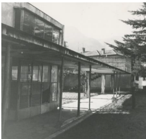
Fig. 4 Como, Asilo Sant'Elia, puntellazioni provvisorie della pensilina esterna con pali lignei, (25 febbraio 1967) © Archivio Terragni, Como.
