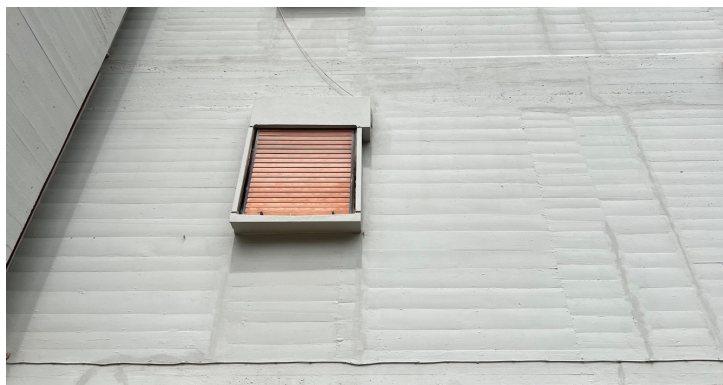
Fig. 6 L'intervento di recupero ha modificato la colorazione e la texture originaria. La sigillatura dei giunti risulta particolarmente evidente, compromettendo l'immagine unitaria del paramento. Edifici residenziali a Sorgane, Firenze (foto C. Piferi, 2025).
