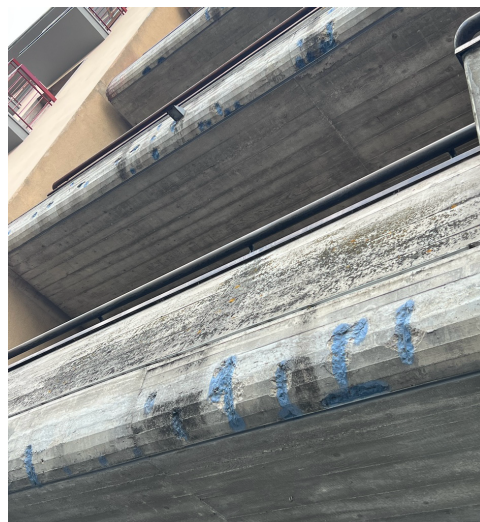
Fig. 1 Interventi di passivazione delle armature su un paramento in Béton Brut . Edificio residenziale a Firenze. La passivazione dei ferri è stata effettuata oltre 10 anni fa (foto C. Piferi, 2025).
