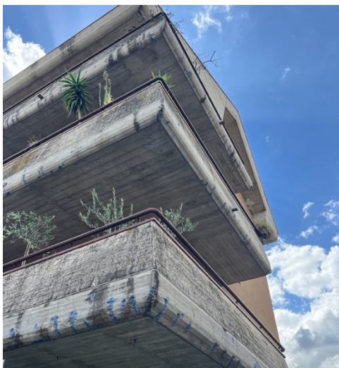
Fig. 1 Interventi di passivazione delle armature su un paramento in Béton Brut . Edificio residenziale a Firenze. La passivazione dei ferri è stata effettuata oltre 10 anni fa (foto C. Piferi, 2025).
