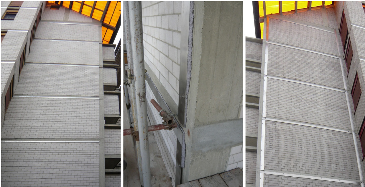
Fig. 2 A sinistra, i paramenti murari prima degli interventi di consolidamento. Al centro, la fase di fissaggio dei piatti in acciaio inox. A destra, il risultato a lavori ultimati. Foto su gentile concessione dei progettisti arch. Guido Aragona e ing. Anna De Agostini.
