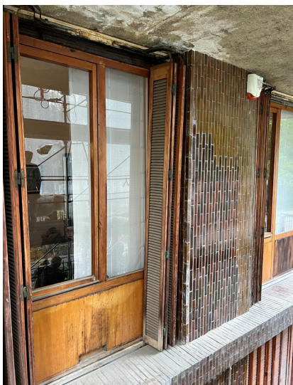
Fig. 3 Porzione di facciata rivestita con elementi ceramici successivi (Archivio Belluschi s.r.l.).
