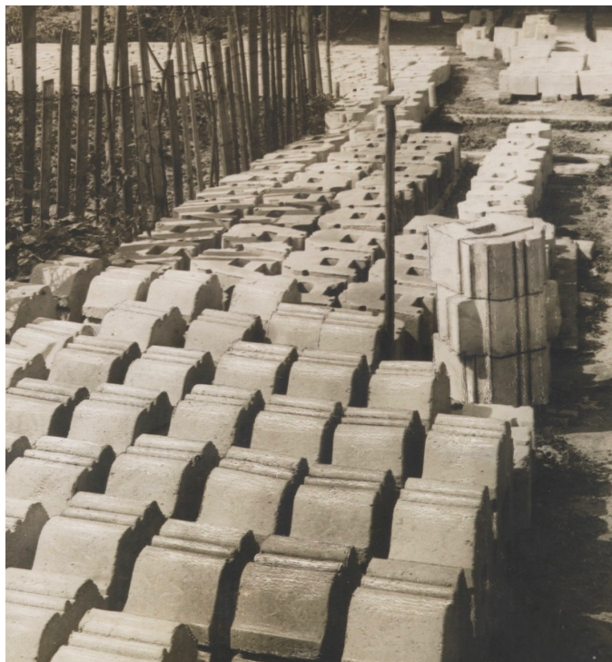
Fig. 2. Parigi, Hotel Jasmin, costruzione della facciata sul Giardino con blocchi di conglomerato cementizio, 1921 © Cooper Hewitt Museum, New York.
