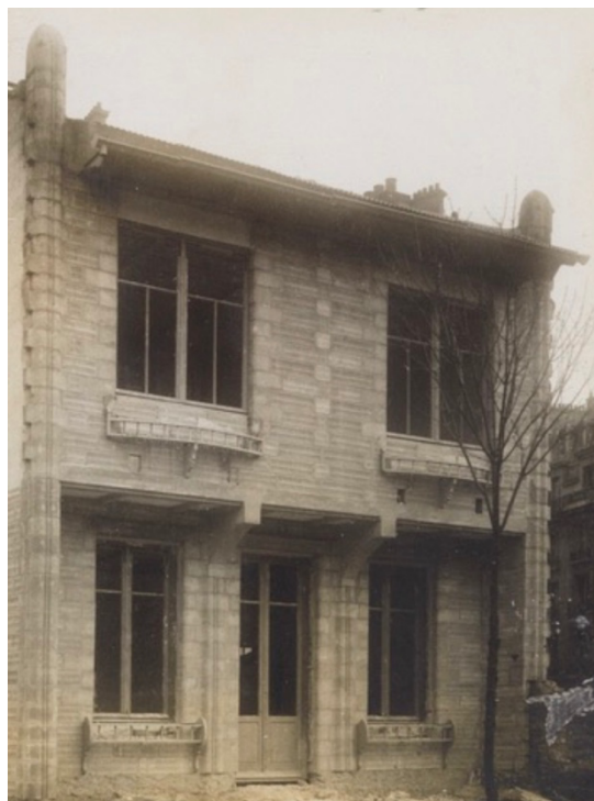
Fig. 2. Parigi, Hotel Jasmin, costruzione della facciata sul Giardino con blocchi di conglomerato cementizio, 1921 © Cooper Hewitt Museum, New York.
