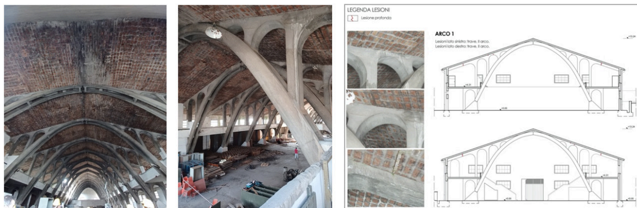
Fig. 2 Roma, capannone Palmanova nella città militare della Cecchignola. A sinistra e al centro, due vedute d'insieme che esibiscono, oltre alla spazialità interna e all'articolazione delle strutture, lo stato di conservazione molto compromesso. A destra, uno stralcio del quadro fessurativo puntualmente restituito per ogni singolo sistema di arcate. Gli elaborati grafici sono a cura di Emiliano Magistri, Federica Paradiso, Gianmarco Piccioni e Laura Schito.
