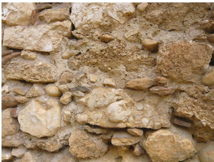
Fig. 5 Particolare di tessitura muraria eterogenea
