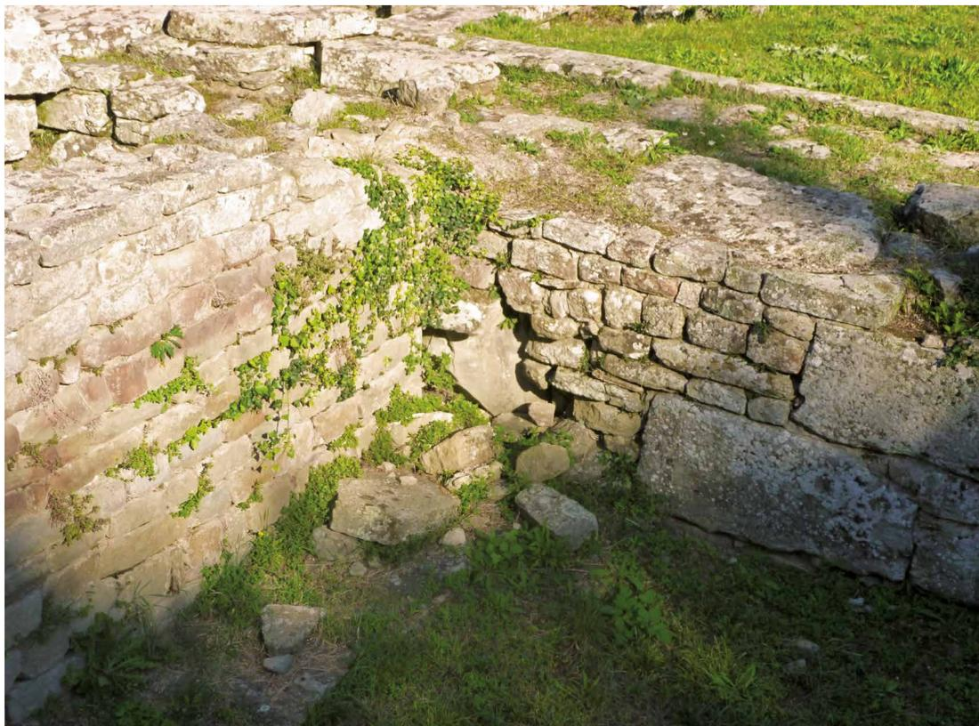
Anche in altri punti dell'area si possono individuare strutture murarie degradate: particolarmente in crisi, nell'area delle terme, il muro che delimitava, sul lato interno, il portico meridionale (Fig. 8) e le strutture del cosiddetto "criptoportico". Anche in questo caso si tratterà di consolidare muraure ancora ben leggibili e delimitate individuando tipologie di materiali di consolidamento che garantiscano una adeguata conservazione.
