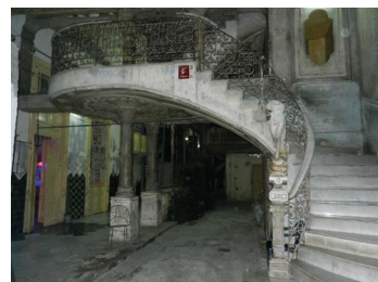
Fig. 4 Interno di un edificio sulla strada Concordia nel quartiere di Centro Habana
