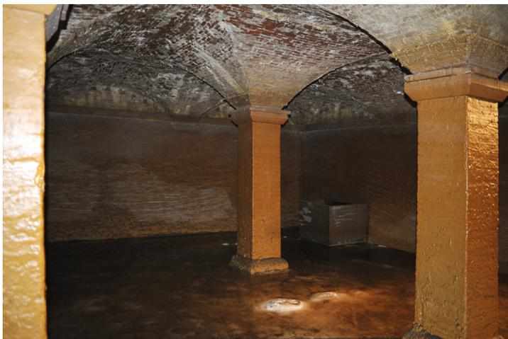
grado piuttosto marcato delle superfici esterne. La fase viene localizzata principalmente al cervello delle volte, sviluppandosi fino all'imposta degli archi, nel punto di collegamento con le colonne sottostanti, e nella porzione di parete messa in luce dal saggio effettuato in prossimità dell'angolo nord-ovest della struttura<sup>24</sup>.
