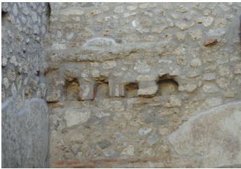
Fig. 10 Pompei, diverse forme degli alloggiamenti delle travi nelle murature: tonde o approssimativamente sgrossate. (foto degli autori, dicembre 2015)
