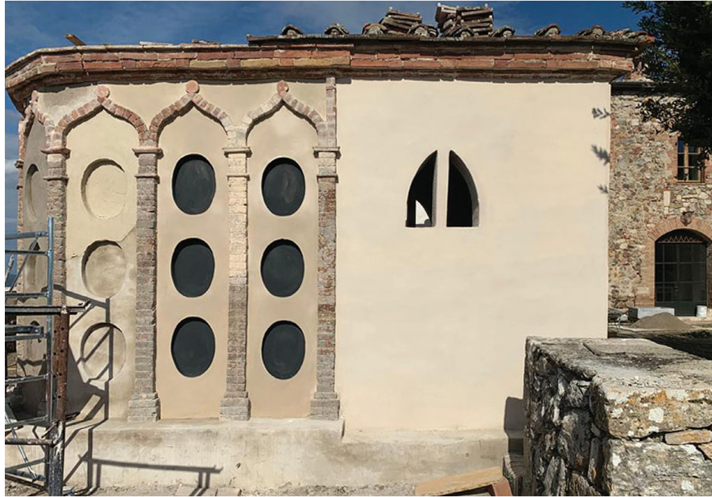
sopra Fig. 25 Rifacimento intonaci lato sud-ovest in corso di esecuzione. (Foto: Clausi G., 2019)
