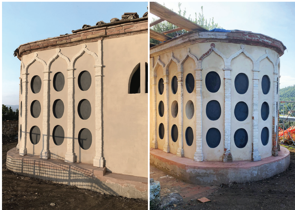
sotto Figg. 26, 27 Ricostituzione del gradone al di sotto degli oculi e rifacimento intonaci su pareti, ovali e paraste in corso di esecuzione. Foto: Clausi G., 2019)
