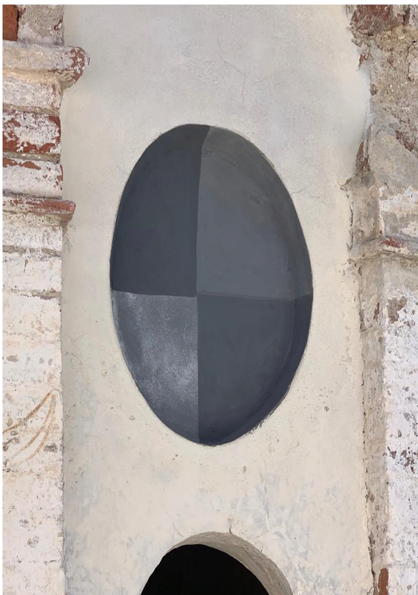
Fig. 21 Particolare delle prove di colore nella fase di ripristino della tinteggiatura degli ovali. (Foto: Clausi G., 2019)
