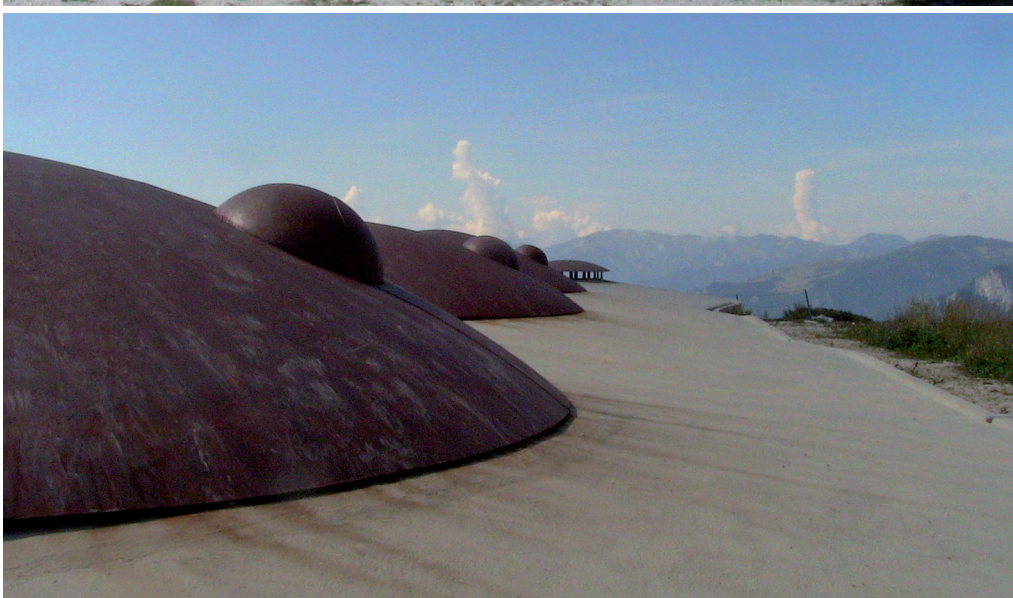
Figg. 9, 10 Forte Campolongo. Facciata sud a restauro ultimato. Sulla copertura si notano i cordini di sicurezza in acciaio. Sotto: le nuove cupole in acciaio Corten. Foto dell'A., agosto 2016.
