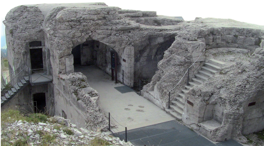
Fig. 7 Forte Verena. Si noti la massicciata di copertura in cui ben si distinguono i tre strati sovrapposti di calcestruzzo. Foto dell'A., agosto 2016.
