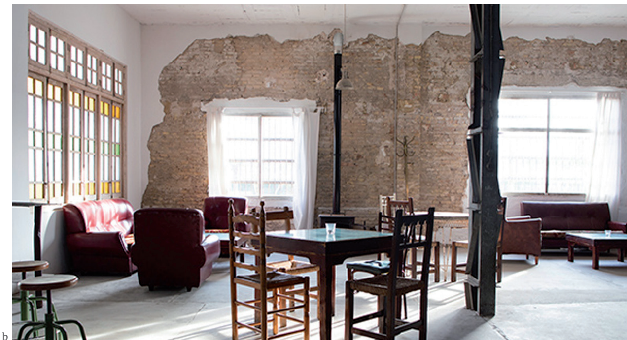
Fig. 12a, b Particolari di alcuni degli ambienti delle naves con il diverso trattamento delle superfici. Foto: < https://conmitropa.blogspot.com/2017/01/la-fabrica-de-hielo-nuevo-espacio-para.html >. Foto: < https://www.lafabrica-dehielo.net/galeria/ >.
