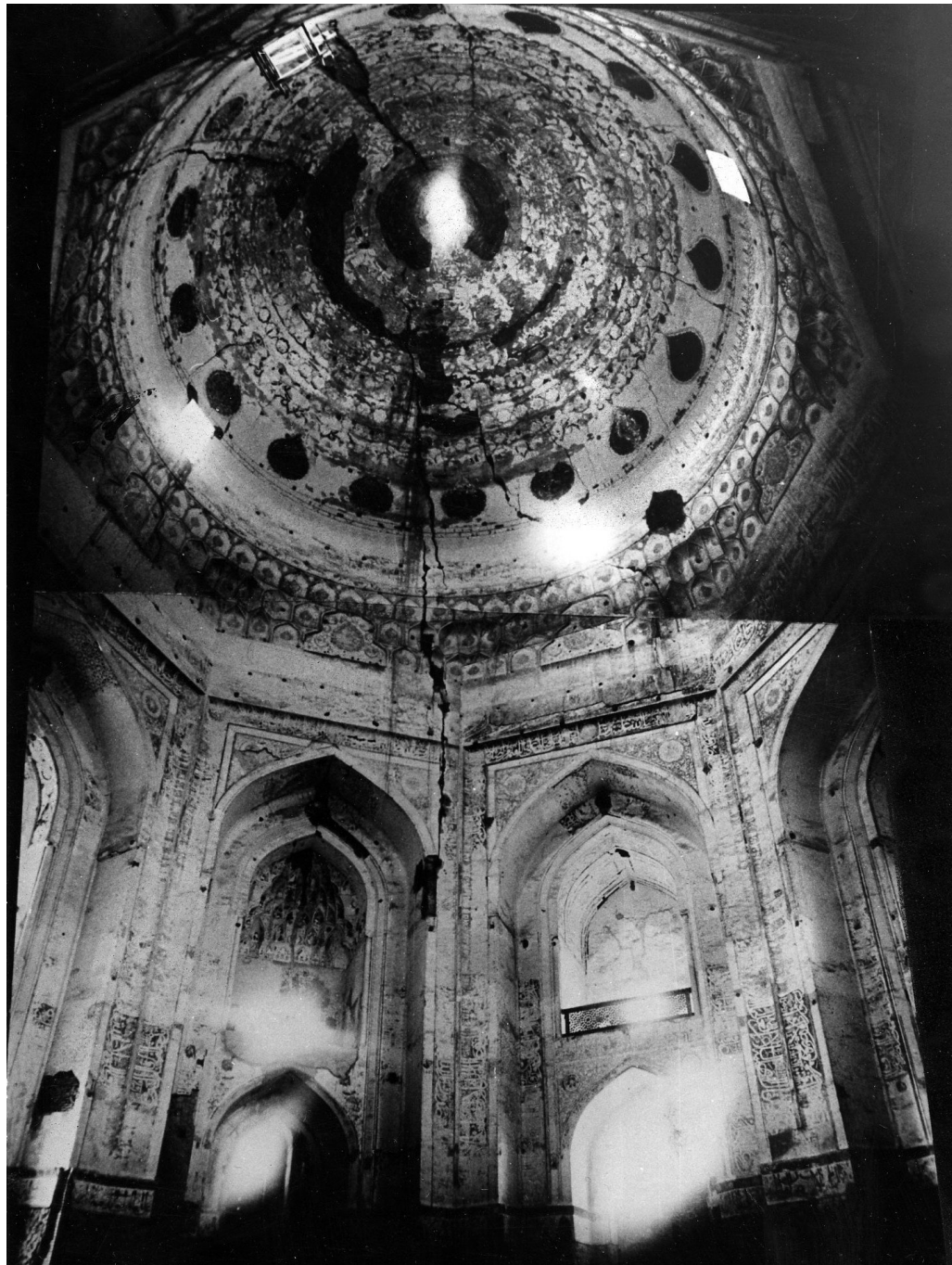
Fig. 8 Foto dell'intradosso della cupola Mausoleo di Oljeitu del 1970 dove vengono indicati con delle frecce i resti dei ponteggi in legno lasciati nella muratura, Iran (UNIFI-AFR 624-28).
