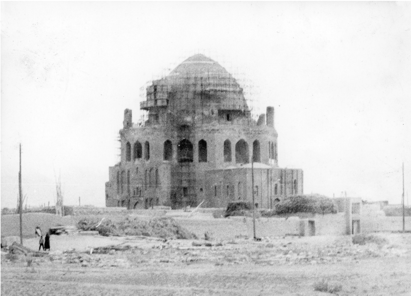
Fig. 14 Il Mausoleo di Oljeitu durante i restauri nel 1973, in questa fase del cantiere si sta intervenendo sull’esterno della cupola, Iran (Foto: Claudio Battistini).
