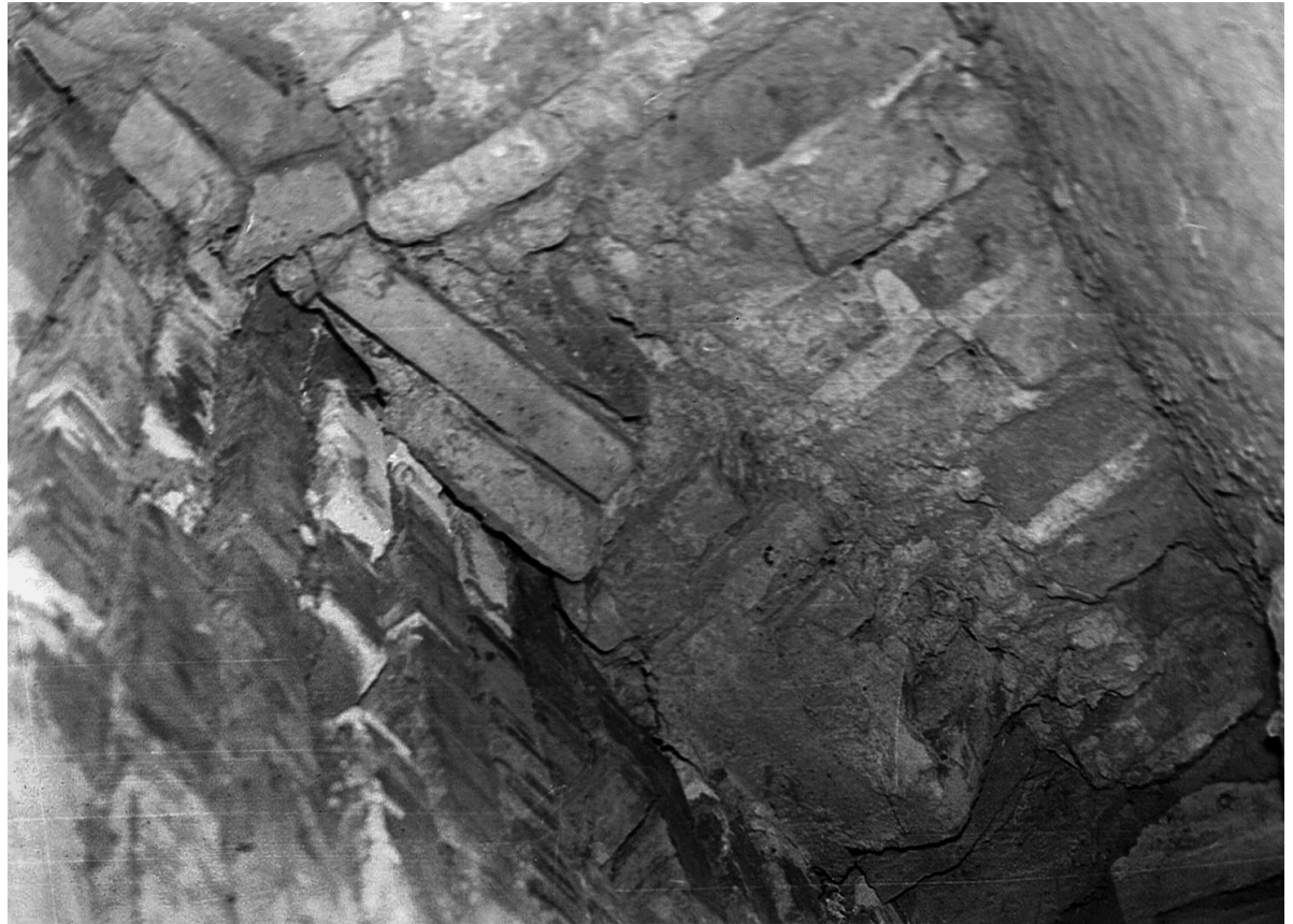
Fig. 10 Vano tra le due calotte della cupola del Mausoleo di Oljeitu nel 1971, da notare uno dei costoloni che connettono le due cupole, Iran (APPS s.n.).
