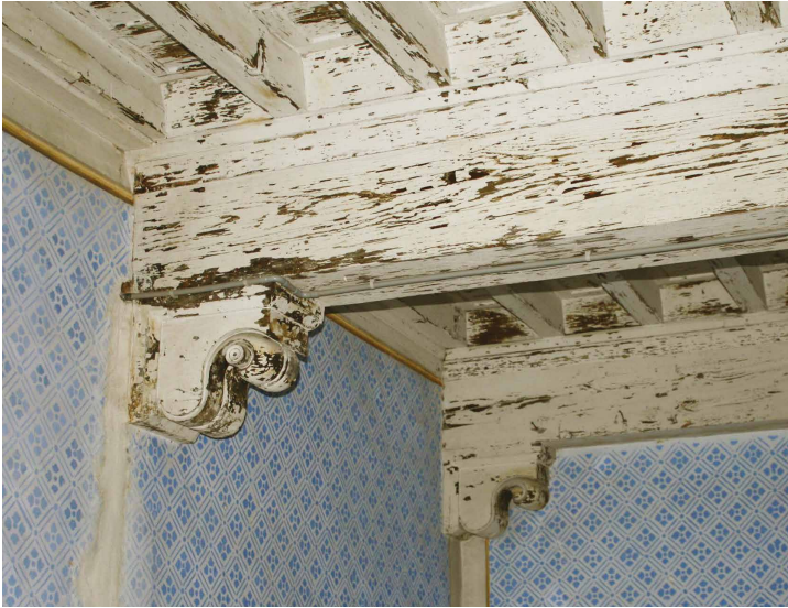
Fig. 9 Particolare delle mensole lignee all'attuale terzo livello della torre. La morfologia e la precisione dei dettagli, unitamente alle dimensioni delle travi hanno portato a sostenere che il piano di calpestio di questo livello non sia originale
