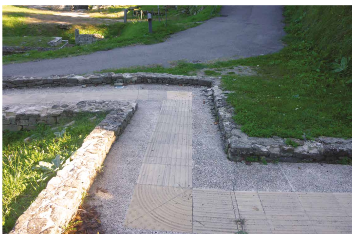
Fig. 13 Struttura di terrazzamento, lato occidentale area
