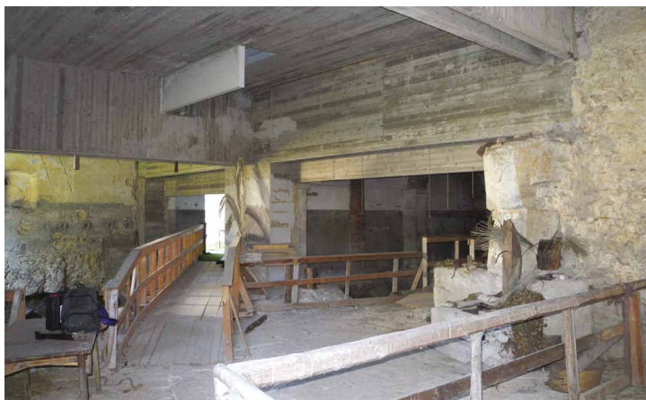
Fig. 11 Vista del piano terra, i nuovi solai e le travi ricalate in cemento armato a doppia ala che appoggiano (a destra) sui resti del sepolcro
