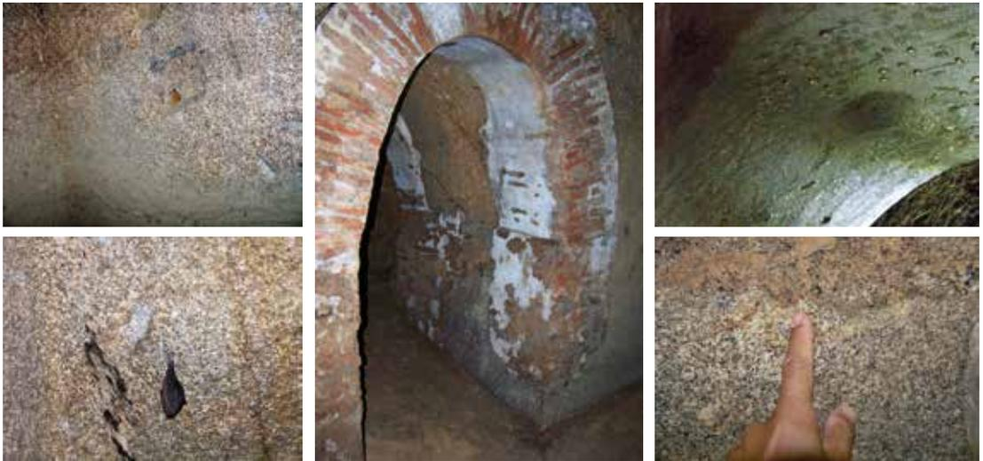
sopralluogo, nell'agosto 2014 (fig. 2.4 e 2.5), sono state rilevate "condizioni ambientali fortemente modificate, con più forti variazioni di temperatura e di umidità, attestate da una condensazione del vapor acqueo in grado di imbibire e saturare gran parte delle superfici con fenomeni di sgocciolamento d'acqua".<sup>1</sup>
