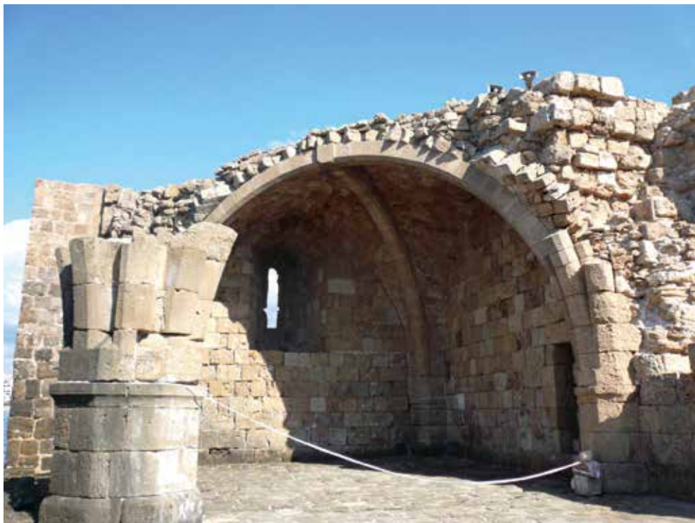
Fig.8 Resti della sala con pilastri polilobati sul lato a mare del castello
