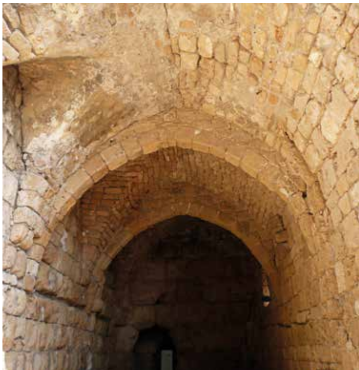
Fig.9 Vano al primo livello della torre settentrionale
