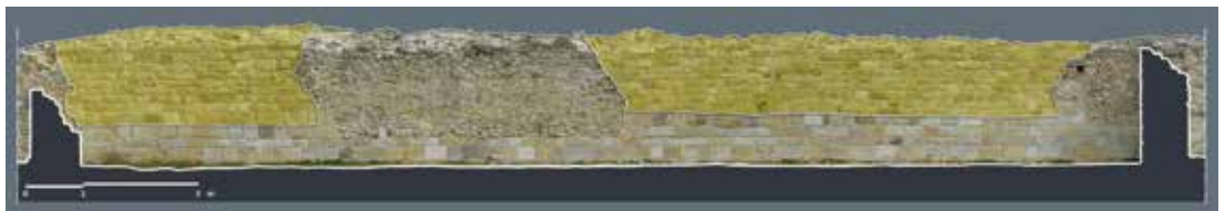
Fig.7 Rilievo fotogrammetrico del paramento esterno del muro Ovest. Sono evidenziate le parti ricostruite dopo i crolli del 2006, scarsamente connotate nel contesto degli apparecchi murari svevi (blocchi regolari) e angioini (elementi sbazzati e ciottolame)
