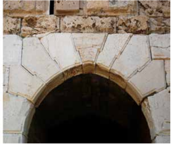
Fig.6 Segni costruttivi nel castello crociato di Byblos (tracciato e realizzazione in opera)
