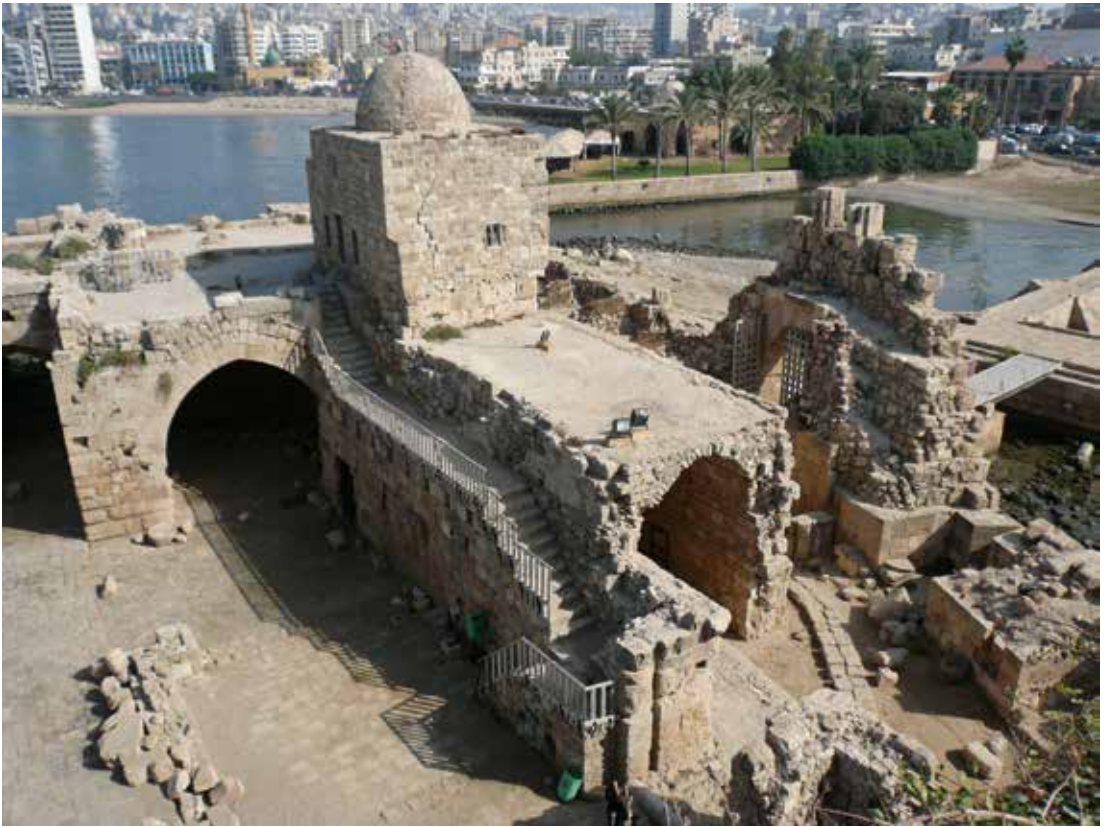
Fig.4 Il complesso fortificato, dalla torre meridionale
