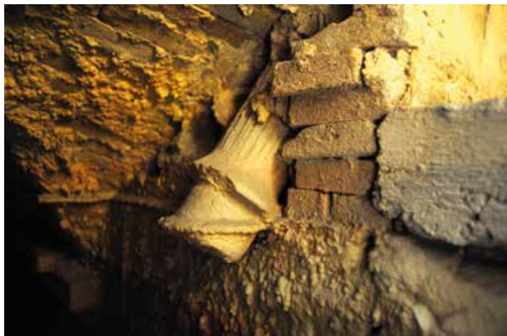
Fig.9, 10 A sinistra uno dei due condotti in ceramica per l'aria tagliati nella muratura della cisterna al momento della costruzione del CF3; a destra uno dei due stipiti in pietra serena presenti nell'ingresso alla cisterna
