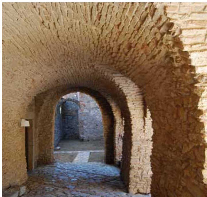
Fig.22 Frazzanò, monastero di San Filippo, portico
