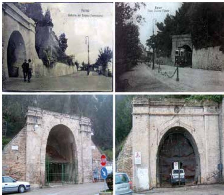
Fig. 6 La galleria Vinci a Fermo: portali di ingresso ed uscita. Immagini storiche e stato attuale
