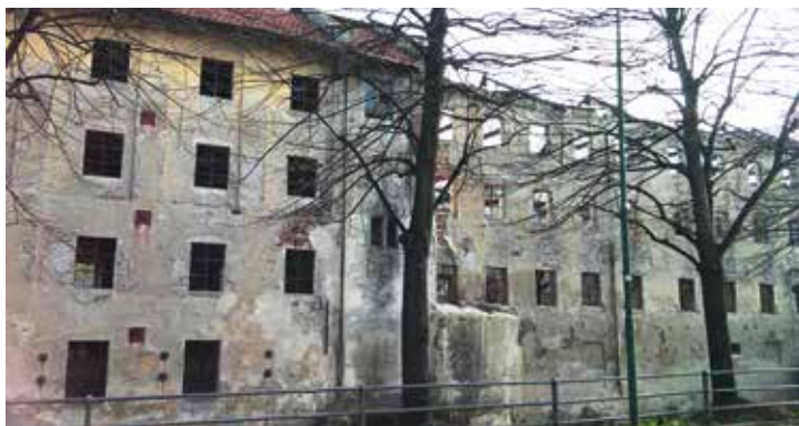
Fig. 19 La parte più antica del Follone e la sua sopraelevazione, caratterizzata dalla presenza di paraste, giustapposta alla porzione ormai a rudere (foto: R. Rudiero)
