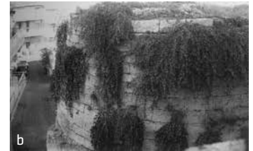
Fig. 2 Carlentini (SR), a. particolare del torrione nord- ovest prima dell’intervento di restauro b. particolare del torrione nord-est prima dell’intervento di restauro
