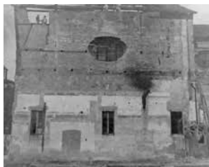
Fig. 1.2 Il prospetto laterale della chiesa di Sant'Eusebio dopo la demolizione degli edifici ad esso addossati. (foto: Fototeca della Biblioteca d'Arte dei Civici Musei del Castello Visconteo di Pavia)
