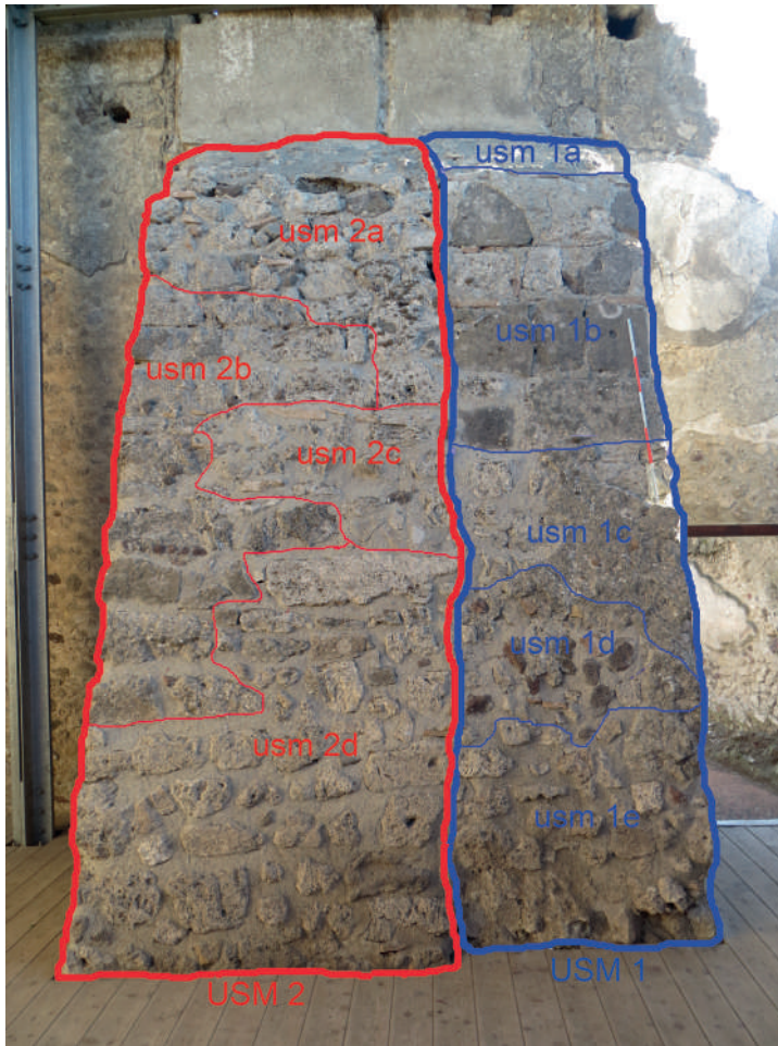
Fig. 12 Lo sperone del destrictarium con evidenziate le unità stratigrafiche individuate
