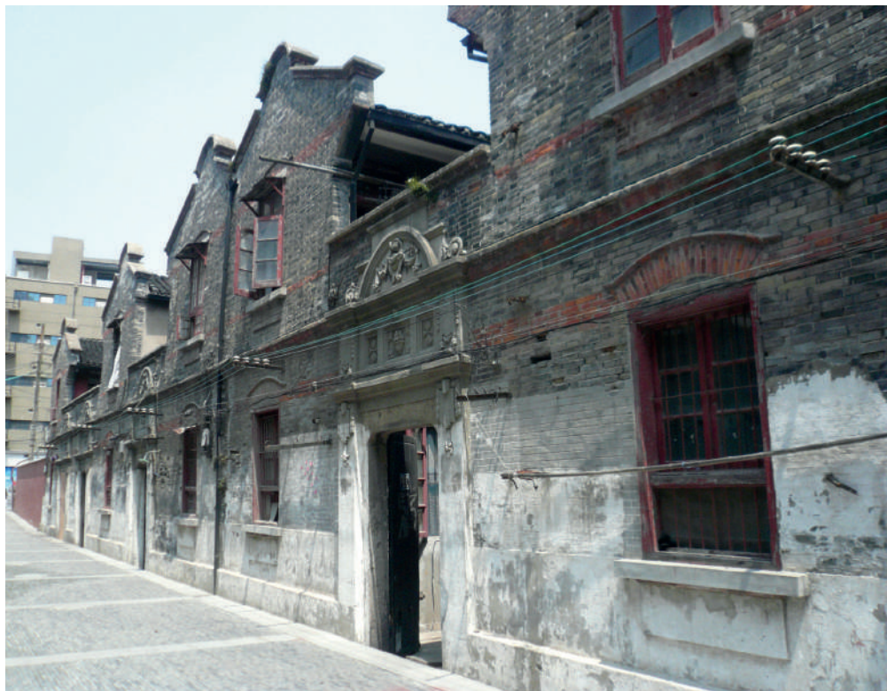
Fig. 24 Waimalu lu, lungo il Pu- river. Edilizia abitativa Shikumen non ancora oggetto di renewal ; sullo sfondo un edificio industriale appena ristrutturato
