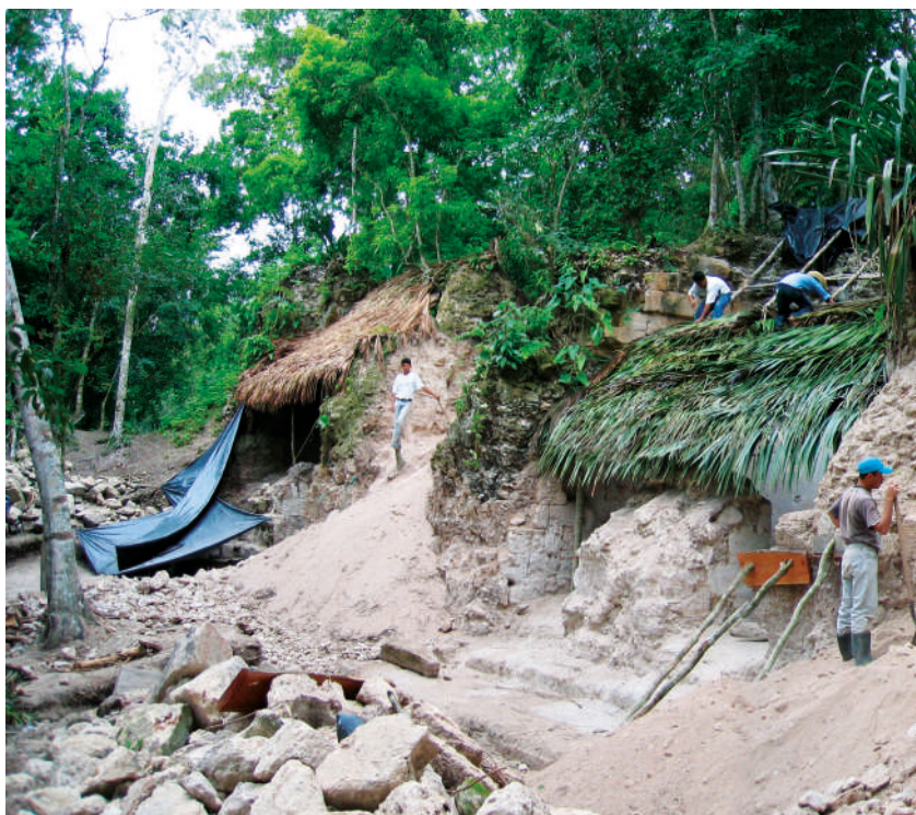
Fig. 4 Ala sur del Palacio 6J2 durante su excavación. (Proyecto La Blanca 2006. Foto A. Peiró)
