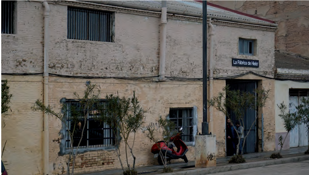
Fig. 10 Attuale accesso al pub ricavato sul lato lungo di una delle navi recuperate. Foto: < https://commitropa.blogspot.com/2017/01/la-fabrica-de-hielo-nuevo-espacio-para.html >.
