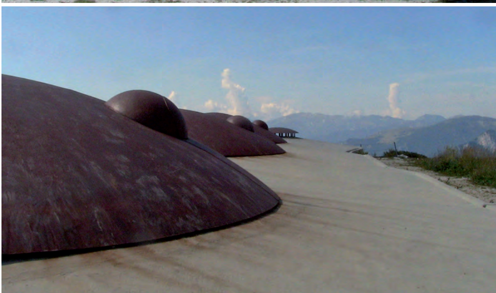
Figg. 9, 10 Forte Campolongo. Facciata sud a restauro ultimato. Sulla copertura si notano i cordini di sicurezza in acciaio. Sotto: le nuove cupole in acciaio Corten. Foto dell'A., agosto 2016.
