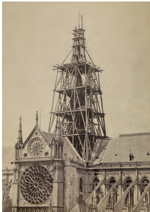
Fig. 30 a Frères Bisson, La flèche en construction , 1859, épreuve sur papier albuminé, 48,4 x 35,2, Ministère de la culture, Médiathèque de l'architecture et du patrimoine, Diffusion RMN-GP.
