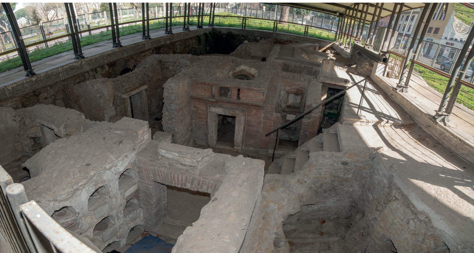
Fig. 1 Roma, Sepolcreto della via Ostiense: visione degli edifici sepolcrali da sud-est Foto A.R. Rubino, C. Santan- gelo, © ICR.
