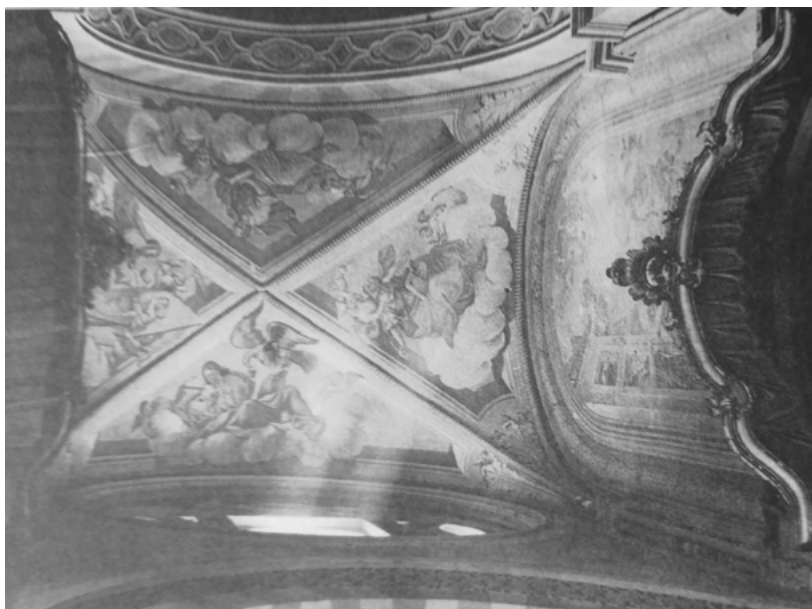
Figura 1. Troia (FG), Concattedrale della Beata Vergine Maria Assunta in Cielo, la volta a crociera adornata dalle pitture del De Rosa © Fototeca SABAP di Bari, neg. 3868/D, 05.10.1957.
