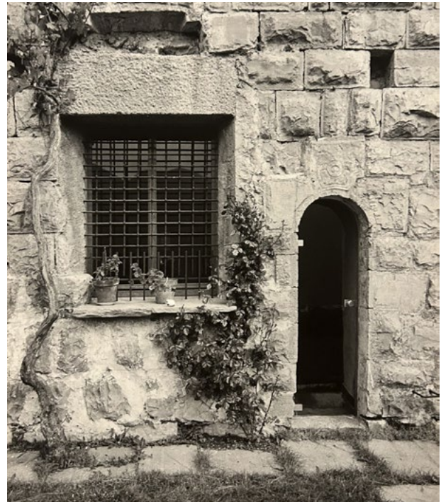
Figura 3. Castello di Bianzano, vista dall'interno di una delle nuove aperture ottenute mediante la sottrazione di conci in pietra esistenti consolidati con gettata in cemento martellinato, con serramento in legno douglas posto sul filo interno (V. Faglia, Diari di cantiere, 1960-1963).
