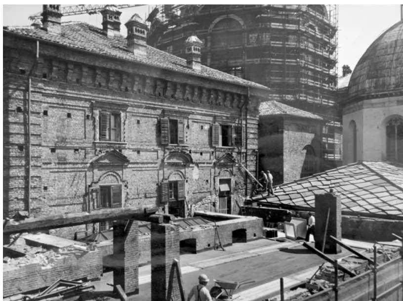
Figura 5. Torino, Palazzo Reale – Manica Nuova, intervento di smantellamento della copertura addossata a Palazzo Reale e al Duomo (SABAP-TO, SBAP-PIE, Torino: Palazzo Reale – Manica Nuova , TO/582/8. Sun concessione del MIC).
