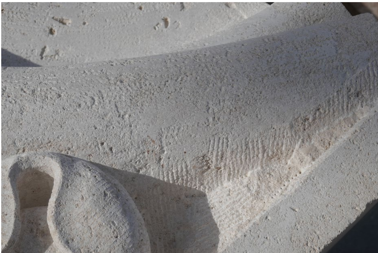
Figure 4. Paris, Notre-Dame, détail d'une taille réalisée à la machine numérique et corrigée à la gradine (photo B. Phalip 2023).
