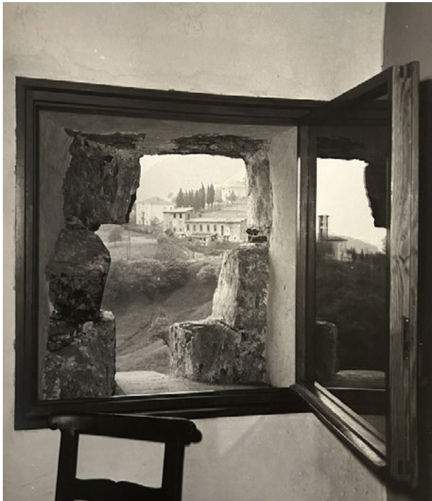
Figura 3. Castello di Bianzano, vista dall'interno di una delle nuove aperture ottenute mediante la sottrazione di conci in pietra esistenti consolidati con gettata in cemento martellinato, con serramento in legno douglas posto sul filo interno (V. Faglia, Diari di cantiere, 1960-1963).
