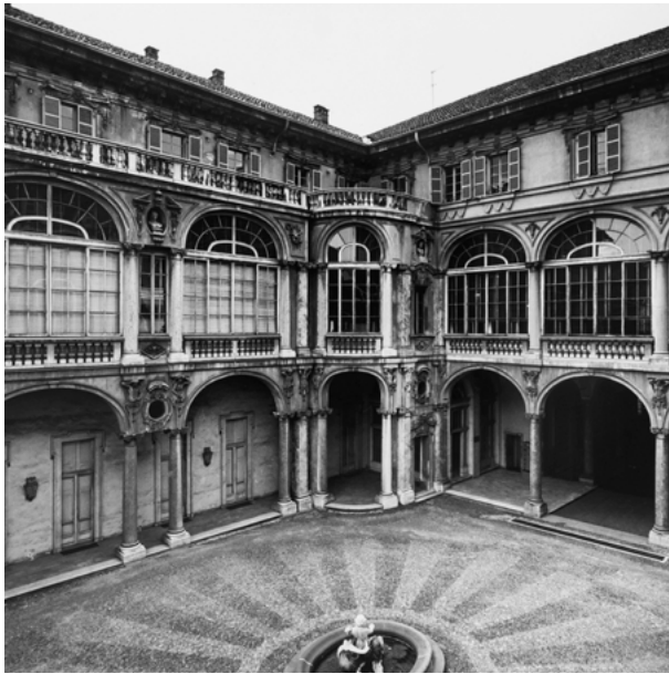
Figura 3. Torino, Palazzo Lascaris, i prospetti porticati sul cortile nel periodo immediatamente precedente l'inizio dei lavori condotti dallo studio Albini e Helg, con le grandi vetrate riquadrate in legno a chiusura delle arcate al piano nobile, (foto 1977) © Archivio storico del Consiglio Regionale del Piemonte, Torino.
