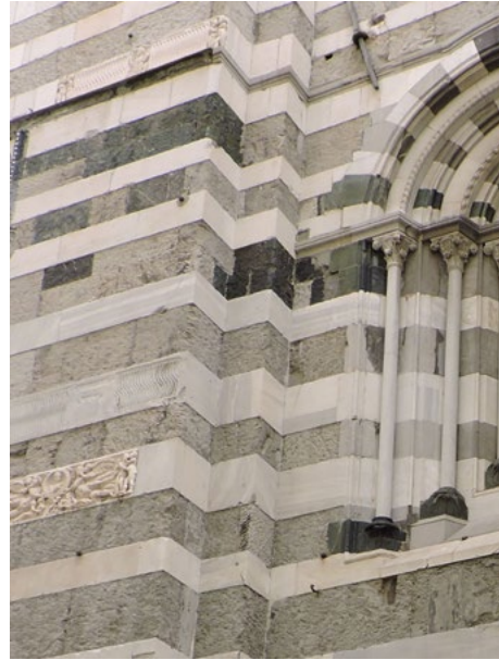
Figura 3. Genova, Cattedrale di San Lorenzo, integrazione di una mensola con stesso materiale trattato superficialmente con una rigatura per renderlo distinguibile, (foto L. Napoleone, 2024).
