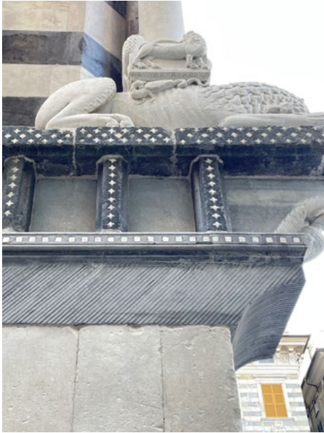
Figura 3. Genova, Cattedrale di San Lorenzo, integrazione di una mensola con stesso materiale trattato superficialmente con una rigatura per renderlo distinguibile, (foto L. Napoleone, 2024).
