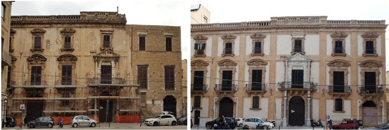
Figura 1. Palermo, Palazzo Ugo delle Favare prima e dopo il recente intervento di restauro del 2023 che ha previsto il completamento nella assoluta continuità dell'esistenze, senza alcuna distinguibilità, dopo i danni causati dai bombardamenti bellici (foto R. Prescia, 2023).
