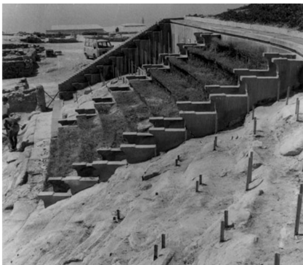
Figura 2. Foto del progetto presentato da Franco Minissi. Montaggio e realizzazione del sistema di profilati. Immagine da: Beatrice Vivio, Transparent restorations: how Franco Minissi has visually connected multiple scales of heritage in "Future Anterior, Journal of Historic Preservation, History, Theory, and Criticism" vol.11, n.2/2014. Trattamento fotografico delle autrici (2024).
