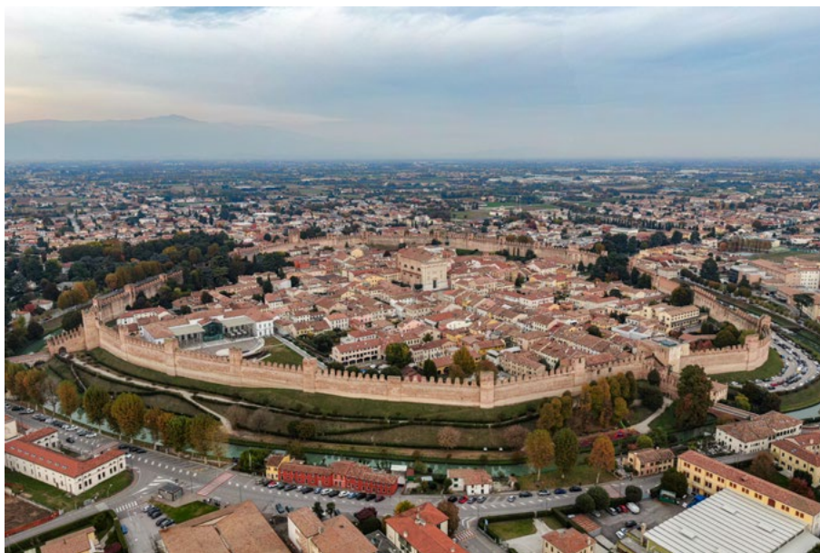
Figura 2. Cittadella (PD), centro storico (foto R. Nadalin, 2023).
