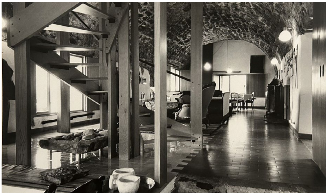
Figura 2. Castello di Bianzano, vista del salone con nuova scala in legno, pavimentazione in grès smaltato giallo-arancione e semi-grès opaco color mattone (V. Faglia, Diari di cantiere, 1960-1963).
