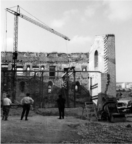
Figura 3. Agrigento, museo archeologico, la fase del cantiere in cui viene montata la struttura indipendente, affiancata alle tre pareti su-perstite dell'ex convento e chiusa dalla nuova parete metallica (© Fondo F. Minissi, ACS, Roma).
