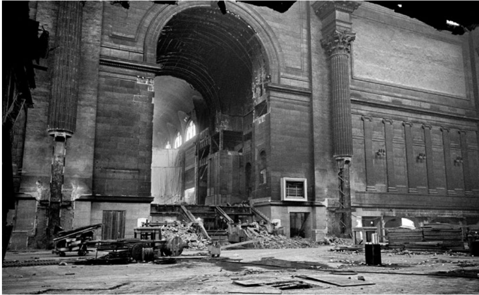
Figura 1. New York City, McKim, Mead e White, Pennsylvania Station, demolizioni in corso (foto E. Hausner, 22 giugno 1964) © The New York Times.
