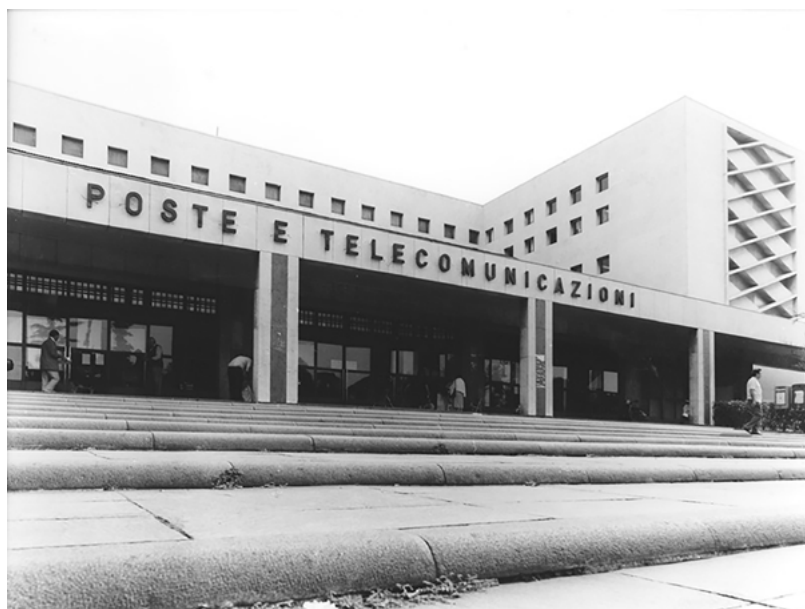
Figura 2. Roma, Palazzo Postale in via Marmorata, Adalberto Libera (1935). Fotografia risalente agli anni Settanta a seguito dell'intervento di rifacimento del rivestimento del portico esterno, completamente diverso per cromie e materiali da quello originario, richiamato esclusivamente dagli inserti in corrispondenza dei pilastri. Archivio Storico di Poste Italiane, foto 77.27.2.6.
