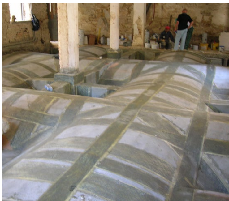
Figura 2. Rinforzo con fasce in FRP all’estradosso di una volta in muratura (A. Balsamo, M. Di Ludovico, G.P. Lignola, A. Prota, Riduzione del rischio sismico del costruito in cemento armato ed in muratura con l’impiego di sistemi avanzati , in Restauro strutturale e riduzione del rischio sismico. Teorie, tecniche e materiali innovativi per il consolidamento , a cura di A. Aveta, Editori Paparo, Roma, 2019, p. 49).
