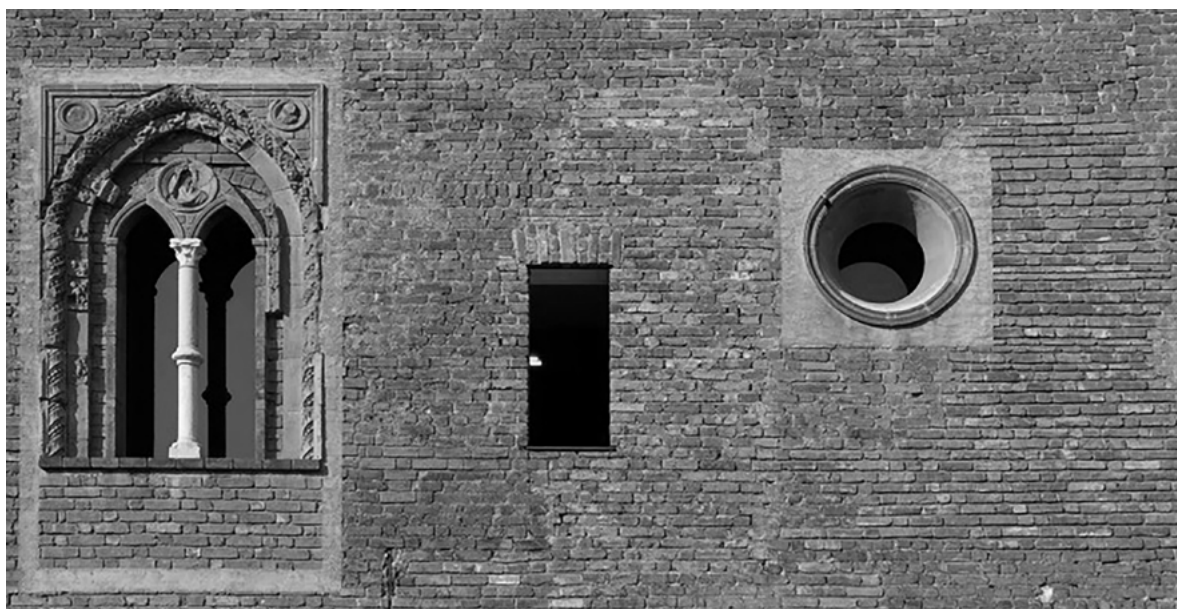
Figura 4. Milano, Ospedale Maggiore, particolare del prospetto su via Francesco Sforza.
