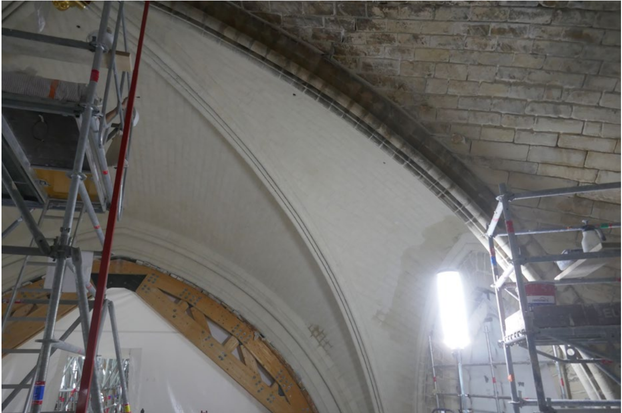
Figure 3. Paris, Notre-Dame, abside ; les voûtes en cours de traitement ; les teintes nuancées du calcaire, les rugosités de l'épiderme disparaissent sous deux couches de badigeons de lait de chaux avec additifs (photo B. Phalip 2023).
