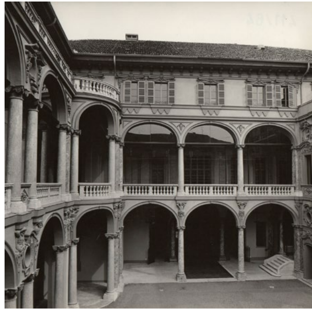
Figura 3. Torino, Palazzo Lascaris, i prospetti porticati sul cortile nel periodo immediatamente precedente l'inizio dei lavori condotti dallo studio Albini e Helg, con le grandi vetrate riquadrate in legno a chiusura delle arcate al piano nobile, (foto 1977) © Archivio storico del Consiglio Regionale del Piemonte, Torino.
