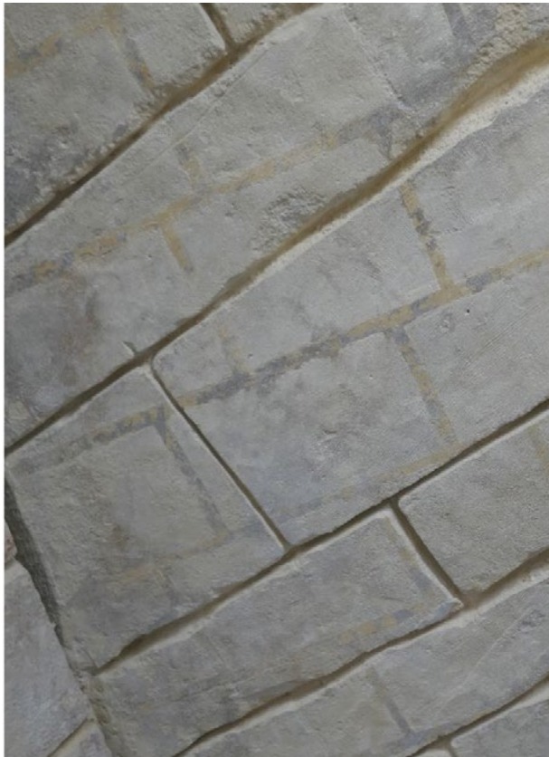
Figure 1. Paris, Notre-Dame, voutain de la nef après nettoyage par enduit de kaolin et décapage. Les traces de taille de pierre ont disparu ; épaufrures, joints dégagés à la disqueuse ; joints simulés quasi invisibles (photo B. Phalip 2022).
