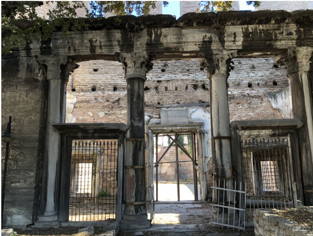
Figura 1. Istanbul, Turchia, chiesa di San Giovanni annessa al monastero di Studios (V sec.), convertita in moschea Imrahor Camii nel XVI sec., danneggiata da incendi e terremoti negli ultimi due secoli. L'edificio, in abbandono da tempo, è da qualche tempo oggetto d'interesse per un possibile intervento di ricostruzione e restituzione alla liturgia islamica (foto D. Fiorani).
