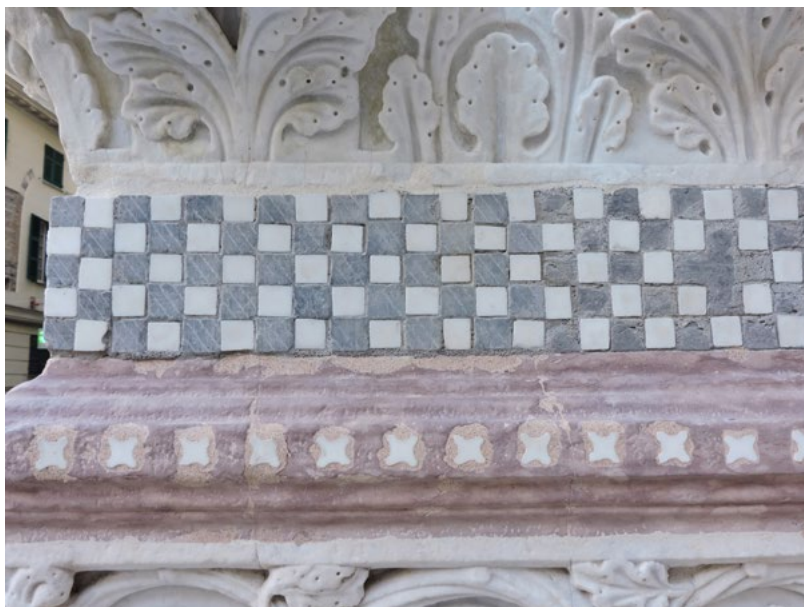
Figura 2. Genova, Cattedrale di San Lorenzo, integrazione di una fascia decorativa con ripresa del motivo e del materiale. Distinguibilità da una visione ravvicinata, garantita dalla differenza di trattamento della superficie, (foto L. Napoleone, 2024).
