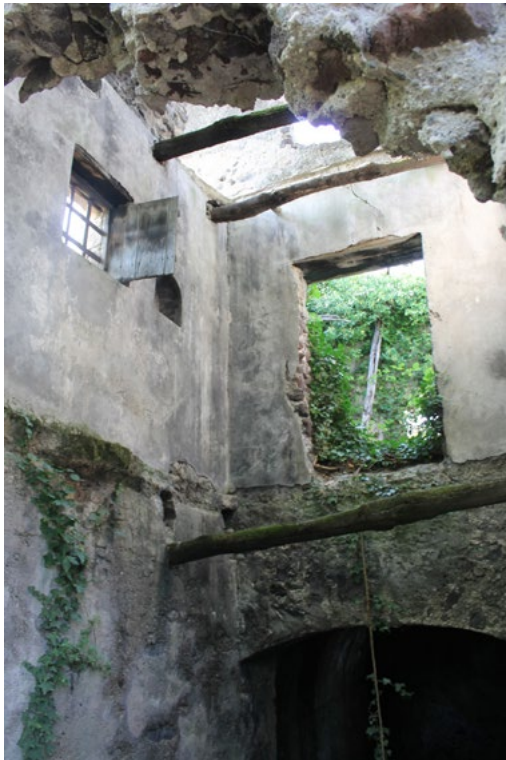
Figura 3. Somma Vesuviana, dissesti di un'architettura rurale alle falde del complesso vulcanico. Qui l'intervento strutturale non può prescindere dai criteri della distinguibilità e della compatibilità meccanica ed estetica (Ragosta, 2023).
