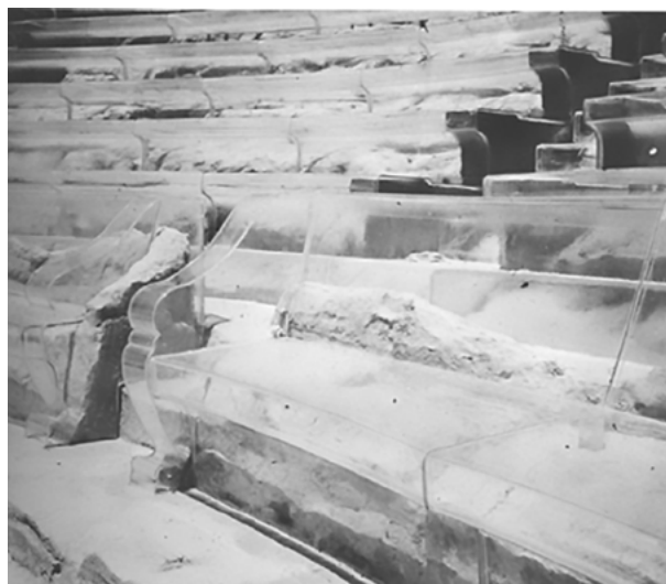
Figura 2. Foto del progetto presentato da Franco Minissi. Montaggio e realizzazione del sistema di profilati. Immagine da: Beatrice Vivio, Transparent restorations: how Franco Minissi has visually connected multiple scales of heritage in "Future Anterior, Journal of Historic Preservation, History, Theory, and Criticism" vol.11, n.2/2014. Trattamento fotografico delle autrici (2024).
