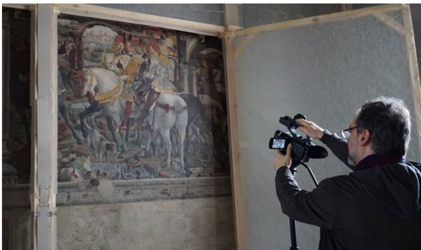
Figura 3. Ferrara, Palazzo Schifanoia, particolare della protezione degli affreschi del Salone dei Mesi durante il cantiere, (foto A. Libro, 2020).
