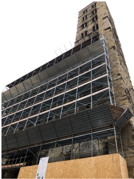
Figura 3. Arezzo, Pieve di Santa Maria, facciata principale, ponteggio per intervento di somma urgenza e messa in sicurezza provvisoria (foto D. Grifo, 2024).
