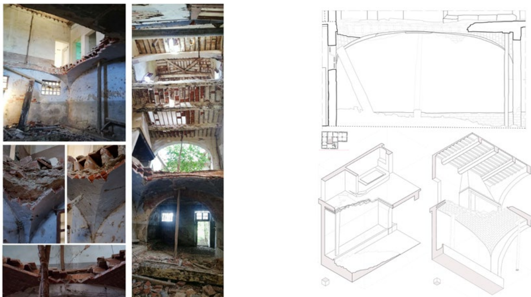
Figura 3. Montepulciano, Leopoldina S. Ferdinando, documentazione delle lacune, (foto G. Angiovini 2021).
