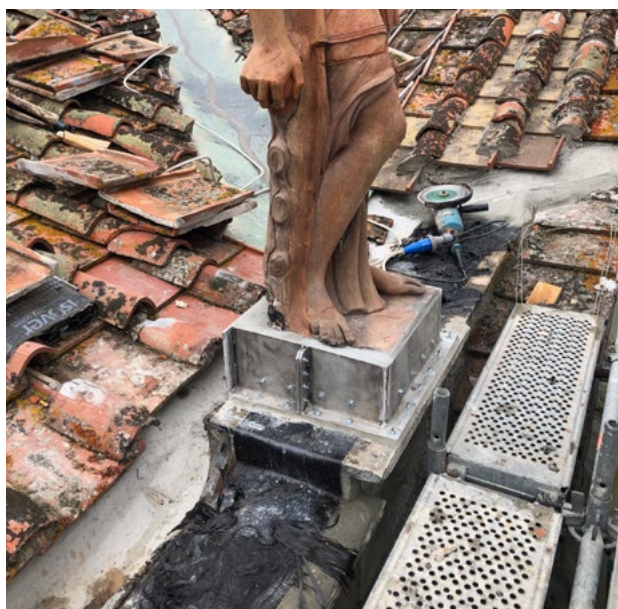
Figura 1. Arezzo, Palazzo Albergotti delle Statue, intervento di consolidamento e ancoraggio delle statue in terra cotta (foto D. Grifo, 2023).
