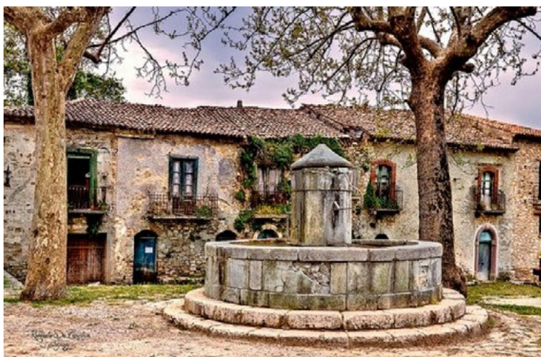
Figura 2. Roscigno Vecchia (SA), privo di abitanti: i continui smottamenti del terreno, già dal 1907/1908, ma anche i danni gravi a seguito del sisma del 1980 in Irpinia, hanno costretto a spostare l'ubicazione del borgo a 2 chilometri di distanza.
