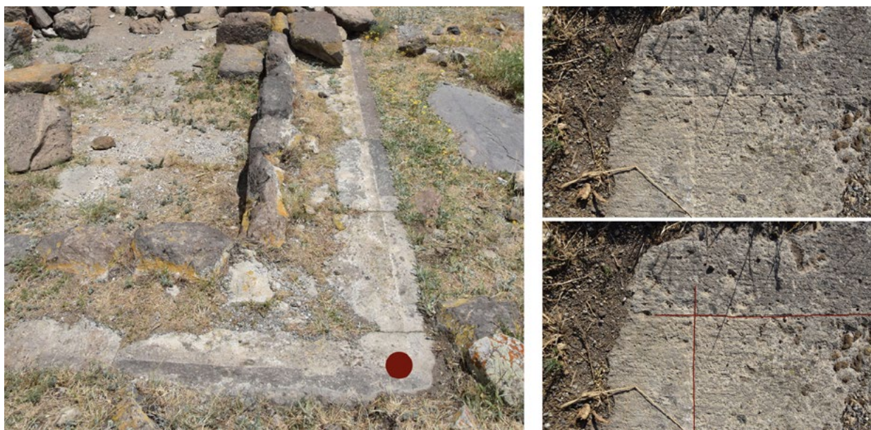
Figura 2. Armenia, regione di Kotayk, cappella di Zoravar, dettaglio del tracciato di cantiere sul concio d'angolo del podio basamentale e relativa localizzazione, (foto M. Zerbini, 2023).
