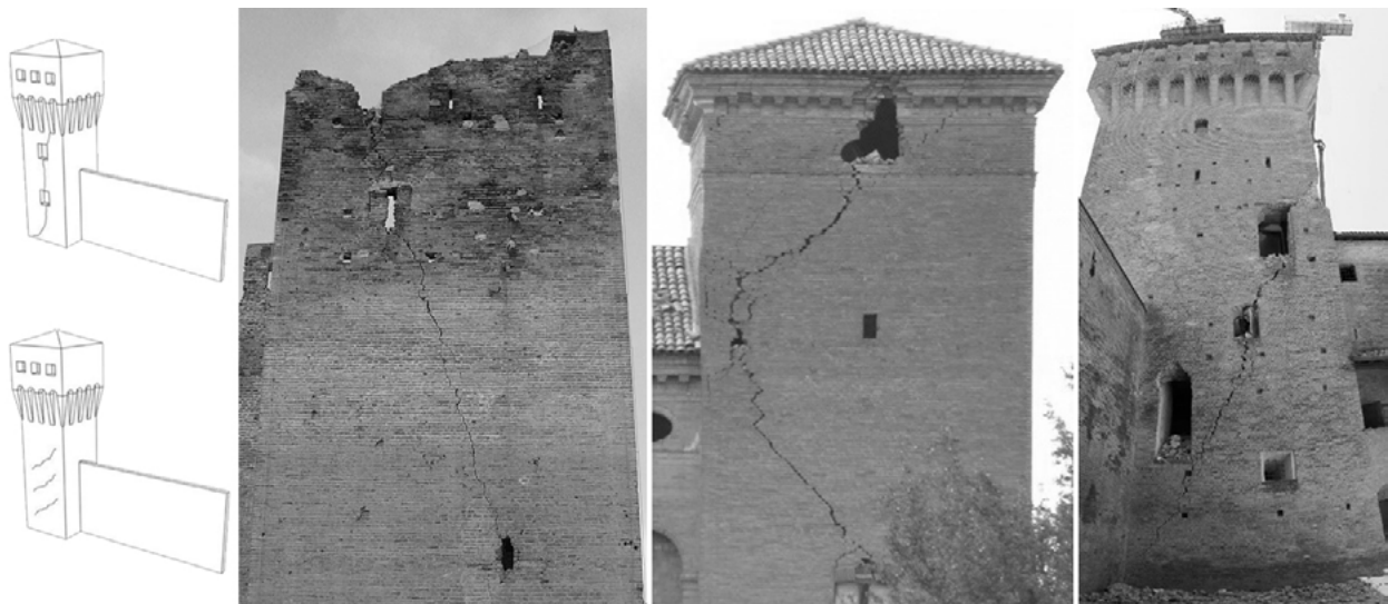
Figura 1. Alcuni esempi di meccanismo a taglio e torsione del fusto della torre. Da sinistra: Reggio Emilia, Rocca di Reggiolo; Modena, Castello delle Torri a San Prospero; Modena, Rocca estense di San Felice sul Panaro (schema grafico E. Lenticchia, foto E. Coisson e D. Ferretti; elab. E. Zanazzi).
