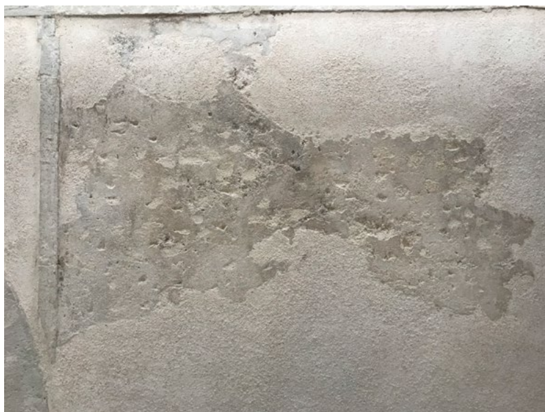
Figura 4. Venezia, fabbrica realtina di Antonio Da Ponte. Dettaglio di intervento di integrazione di intonaco a marmorino. Progetto e direzione lavori arch. Massimo Gin, esecuzione Lithos restauri s.r.l. (foto F. Trovò, 2022).
