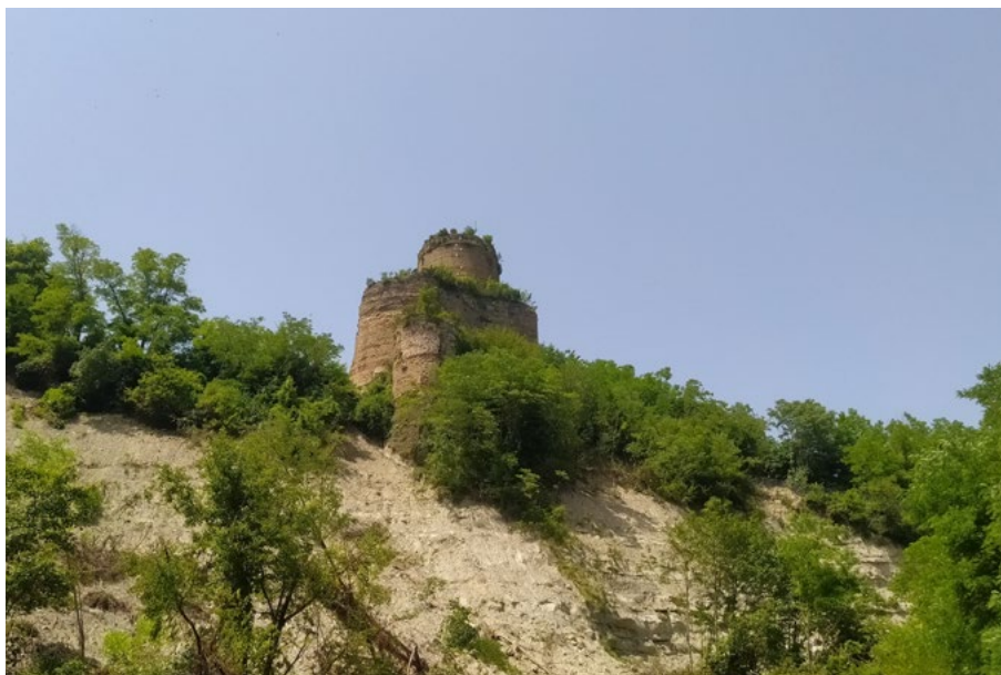
Figura 3. Modigliana (FC), Rocca dei Conti Guidi, movimento franoso del versante su cui sono costruite le strutture di elevazione, (foto D. Indelicato 2023) © Archivio SABAP-RA, Ravenna.
