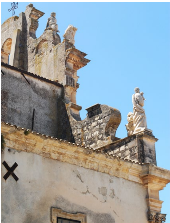
Figura 3. Vizzini (CT), Chiesa di San Giovanni Battista, veduta posteriore del fastigio sommitale alla facciata principale, parzialmente ricostruito nell'intervento del Lojacono (foto F. Giuffrè, 2023).
