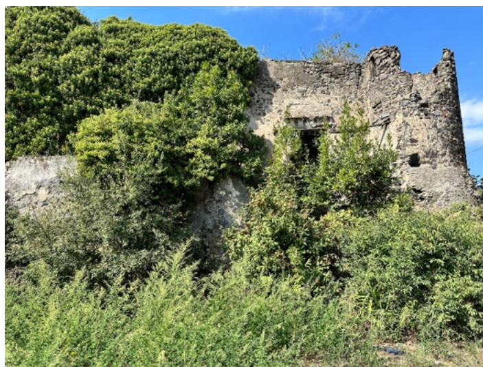
Figura 2. Somma Vesuviana, Torretta Fasano (foto A. Ragosta, 2023).
