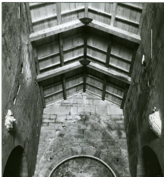
Figura 4. Matrice, chiesa di Santa Maria della Strada, la navata principale dopo la rimozione delle volte (ASABAP MOL, 1969).
