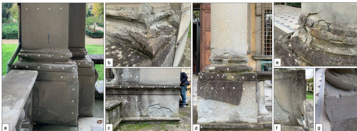
Figura 1. a, b e c) Colonna 1 con relative forme di degrado e d, e, f e g) Colonna 2 con relative forme di degrado.
