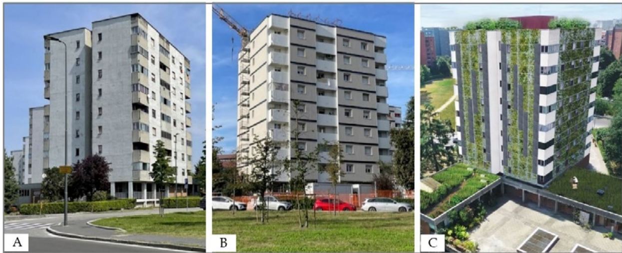
Figura 1. A-C Torri ALER di via Russoli (MI) prima dell'intervento (A), durante (B), in fase di esercizio (C) dopo l'auspicata crescita della vegetazione: la collaborazione pubblico/privato ha consentito l'intervento a scala condominiale; © https://blog.urbanfile.org/ , 2024.
