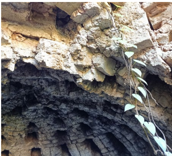
Figura 3. Messina, Particolare della volta traforata in fase di crollo della fornace per laterizi A009 (foto A. Chillemi, 2024).
