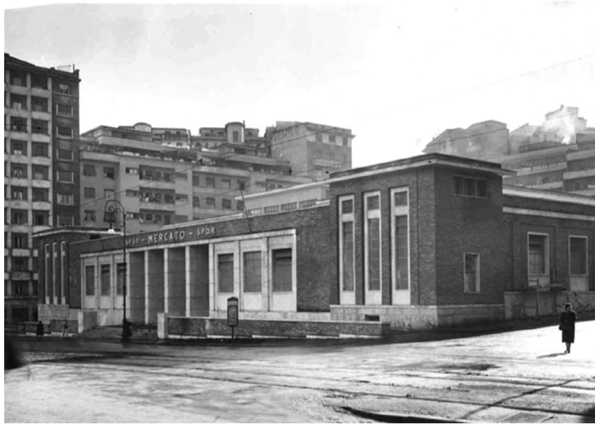
Figura 3. Roma, via Catania, mercato Italia (S. Cutarelli, La documentazione dei cantieri per l'edilizia anonaria: il caso del mercato Italia a Roma, in «Patrimonio Industriale», XVI, 2022, 24, p. 109).
