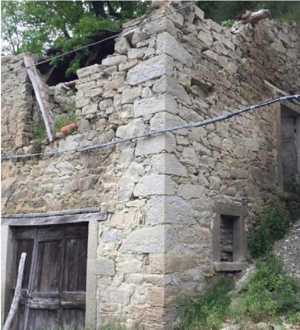
Fig. 1 Tipologia prevalente di muratura presente negli edifici di Vezzano (foto E. Petrucci).
