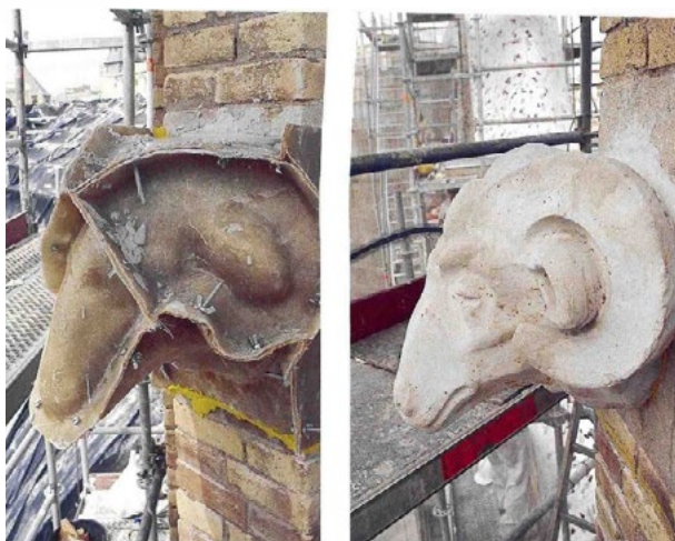
Fig. 5. Valencia, Mercato Colón, reintegrazione di elementi ornamentali con getto in stampi (foto Oscar Bustos, 2003)
