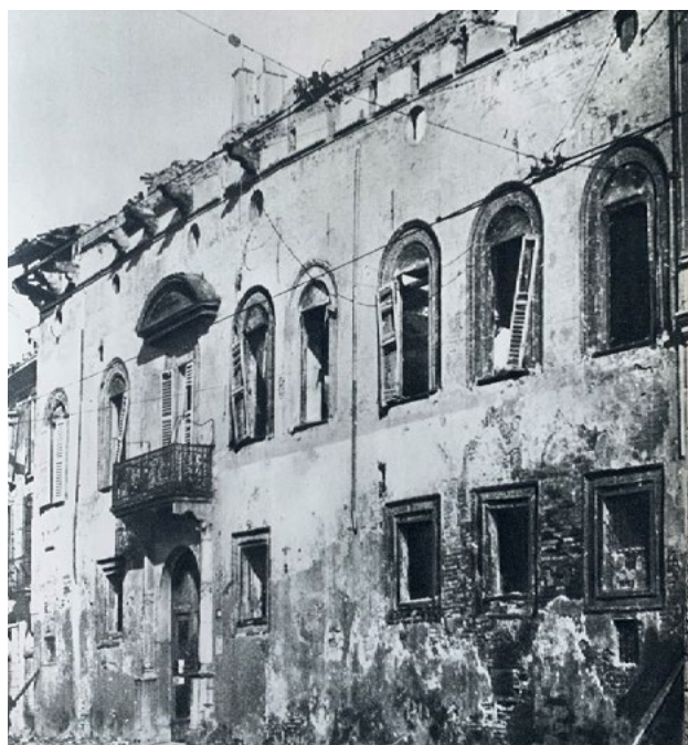
Fig. 1 Milano, Casa Silvestri, facciata principale su corso Venezia a seguito dei bombardamenti, da Rosa, Reggiori 1962.
