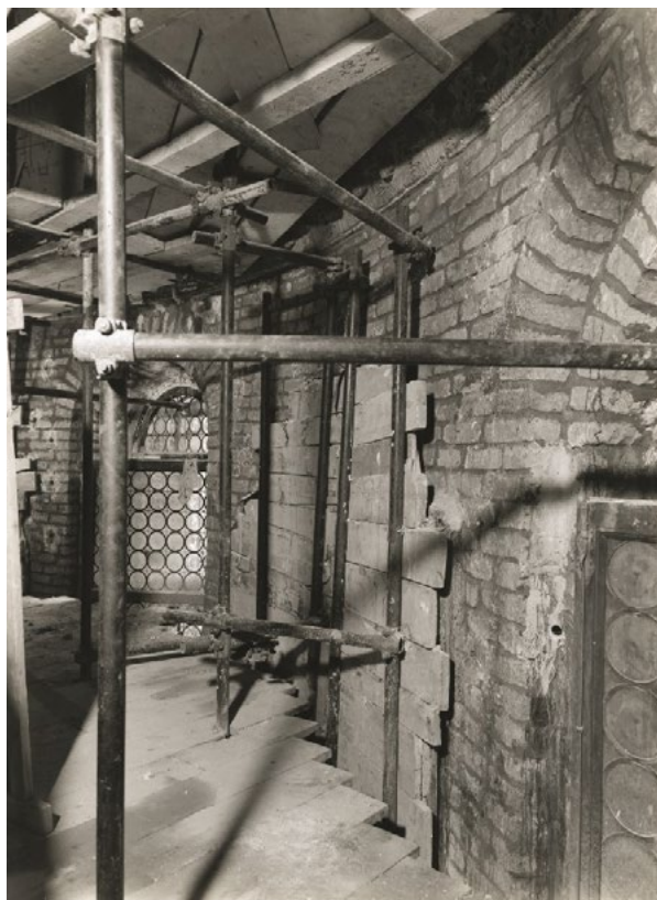
Fig. 2. Opere provvisorie per le murature dell'abside maggiore durante le iniezioni cementizie a pressione, (Università Iuav di Venezia, Archivio Progetti – Fondo Ferdinando Forlati)
