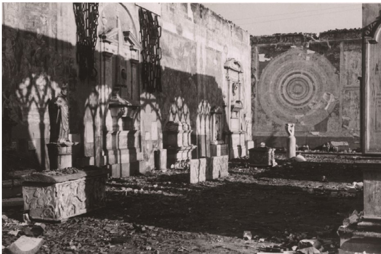
Fig. 3 Pisa, Camposanto Vecchio dopo l'incendio del 27 luglio 1944. Il soprintendente Piero Sanpaolesi avvia i lavori di recupero dei lacerti e le operazioni di stacco degli affreschi, avvalendosi di una quadra operativa di valenti restauratori tra cui Leone Lorenzetti e Leonetto Tintori con il supporto scientifico dell'Istituto Centrale del Restauro diretto da Cesare Bandi (foto di J. B. Ward Perkins, British School at Rome Archive, Ward-Perkins Collection, wpward 0840)
