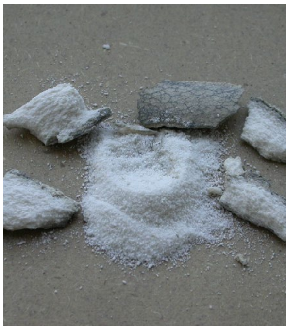
Fig. 2. Venezia, Chiesa di S. Maria di Nazareth (degli Scalzi), Documentazione fotografica del campione 4041/6 prelevato dalla facciata, (foto M. Baldan, 2015 in Archivio SABAP-VE-LAG).
