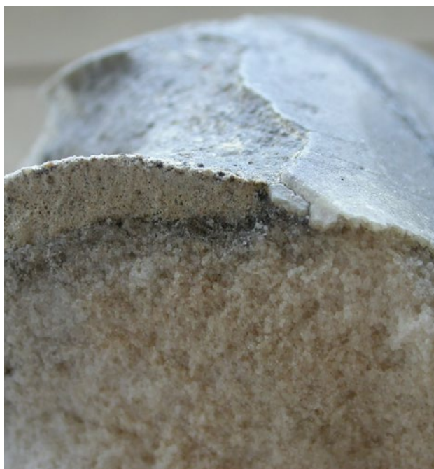
Fig. 1. Venezia, Chiesa di S. Maria di Nazareth (degli Scalzi), Documentazione fotografica del campione 4041/7 prelevato dalla facciata, (foto M. Baldan, 2015 in Archivio SABAP-VE-LAG).
