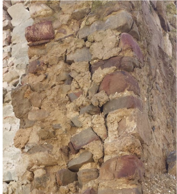
Fig. 2 Il nucleo murario formato da elementi di dimensioni varie cementati con abbondante malta di calce (foto E. Petrucci)
