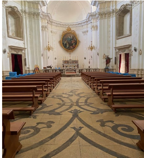
Fig. 6 Siracusa, chiesa di S. Filippo Neri, pavimento aula, si notano i banchi di legno che danneggiano le pietre restaurate (foto O. Schillaci, 2023)
