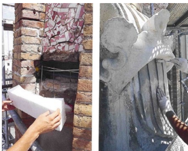
Fig. 6. Valencia, Mercato Colón, consolidamento e reintegro delle sculture ornamentali (foto Oscar Bustos, 2003)
