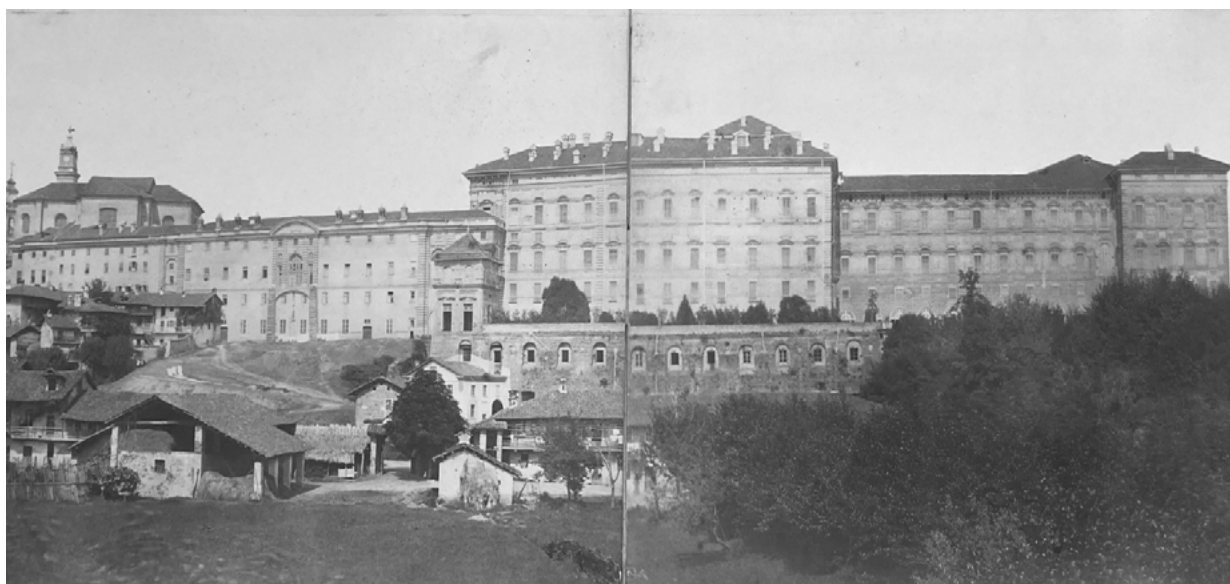
Fig. 2 Agliè, il fronte ovest del Castello di in una veduta di inizio '900 (Politecnico di Torino, Biblioteca Centrale di Architettura, Sezione Libri Rari, Vedute del Castello di Agliè , raccolta fotografica, s.d.).
