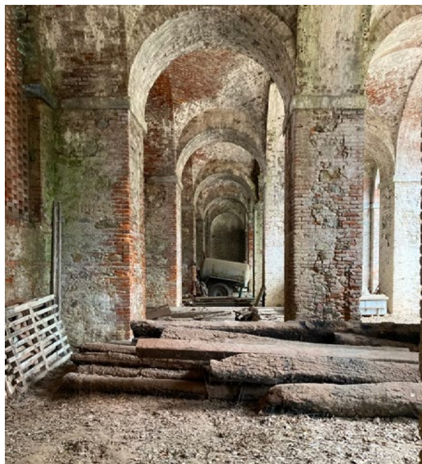
Fig. 9 Agliè, una delle campate interne del Ponte Rosso, ora utilizzato come deposito (foto G. Beltramo 2023).
