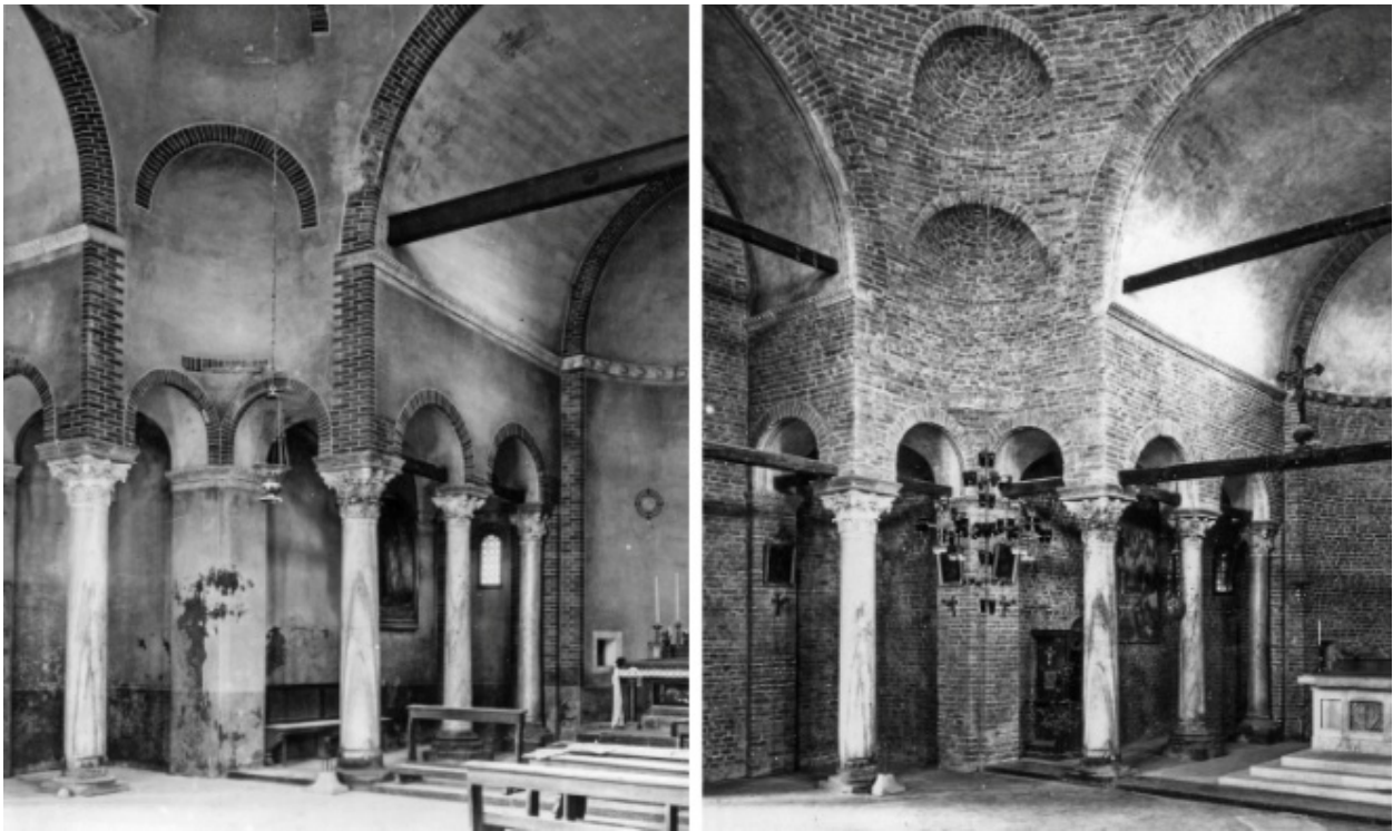
Fig. 2. Torcello, chiesa di S. Fosca: a sinistra, prima dei Lavori di Forlati del 1929-1938, si nota la presenza dei tiranti lignei del braccio absidale (solo all'imposta dell'arcone) e delle due arcate del presbiterio, inoltre le superfici intonacate nella fase dell'intervento di Berchet-Rupolo (1911-1915) con campiture bianche e finti mattoni nelle angolate e nelle arcate (foto del giugno 1929) (SABAPVeLag); a destra, Torcello, chiesa di S. Fosca, dopo i lavori di Forlati del 1929-1938, si nota l'incremento dei tiranti lignei negli arconi dei bracci della croce e in tutte le arcate e la rimozione intonaco precedente lasciando muratura a vista e volte intonacate di bianco con filetti perimetrali di colore blu e rosso (foto del ottobre 1938) (SABAPVeLag)
