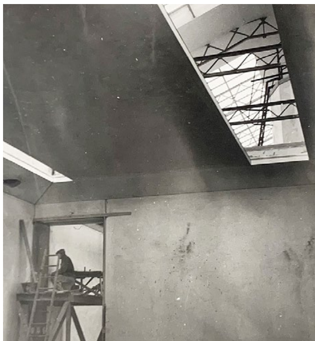
Fig. 2 Torino, Galleria Sabauda. P. Sanpaolesi, cantiere di restauro, 1954 ca. APPS, F4, inserto 12, Galleria Sabauda, fotografie
