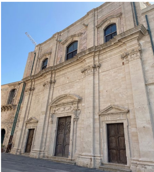
Fig. 1 Siracusa, chiesa di S. Filippo Neri, prospetto nord-est (foto O. Schillaci, 2023)
