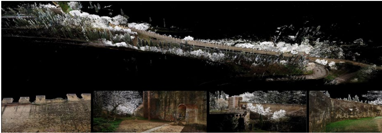
Fig. 4 Alcune immagini del database point cloud integrato. La nuvola di punti oltre ad essere altamente descrittiva della tessitura muraria, permette la lettura colorimetrica del manufatto riportando l'immagine dello stato di conservazione alla data del rilievo effettuato.
