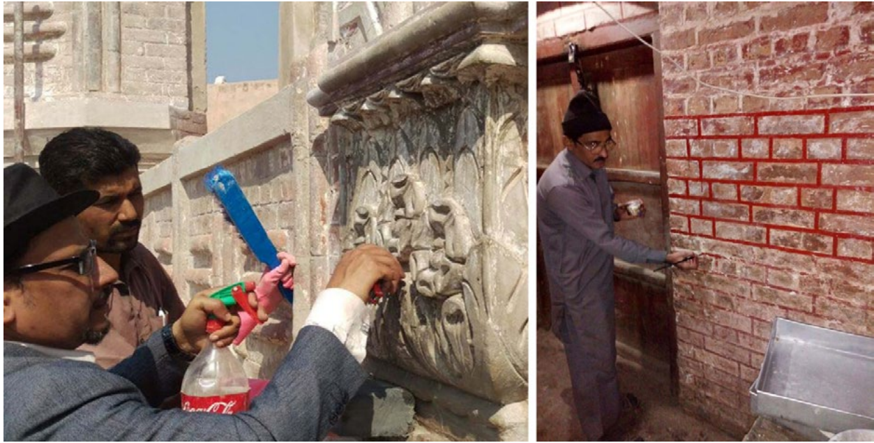
Fig. 3. Pakistan, Multan Walled City. A sinistra: Haram Gate, prove di pulitura. A destra: Musafir Khana, "rifacimenti" decorativi dei giunti (foto degli autori, 2018).
