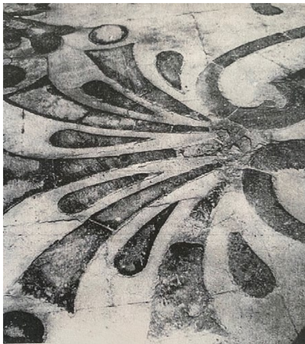
Fig. 4 Siracusa, chiesa di S. Filippo Neri, pavimento, parte destra prima del restauro, particolare, si notano abrasioni, disgregazioni e lacune (foto Lojacono, 1962)
