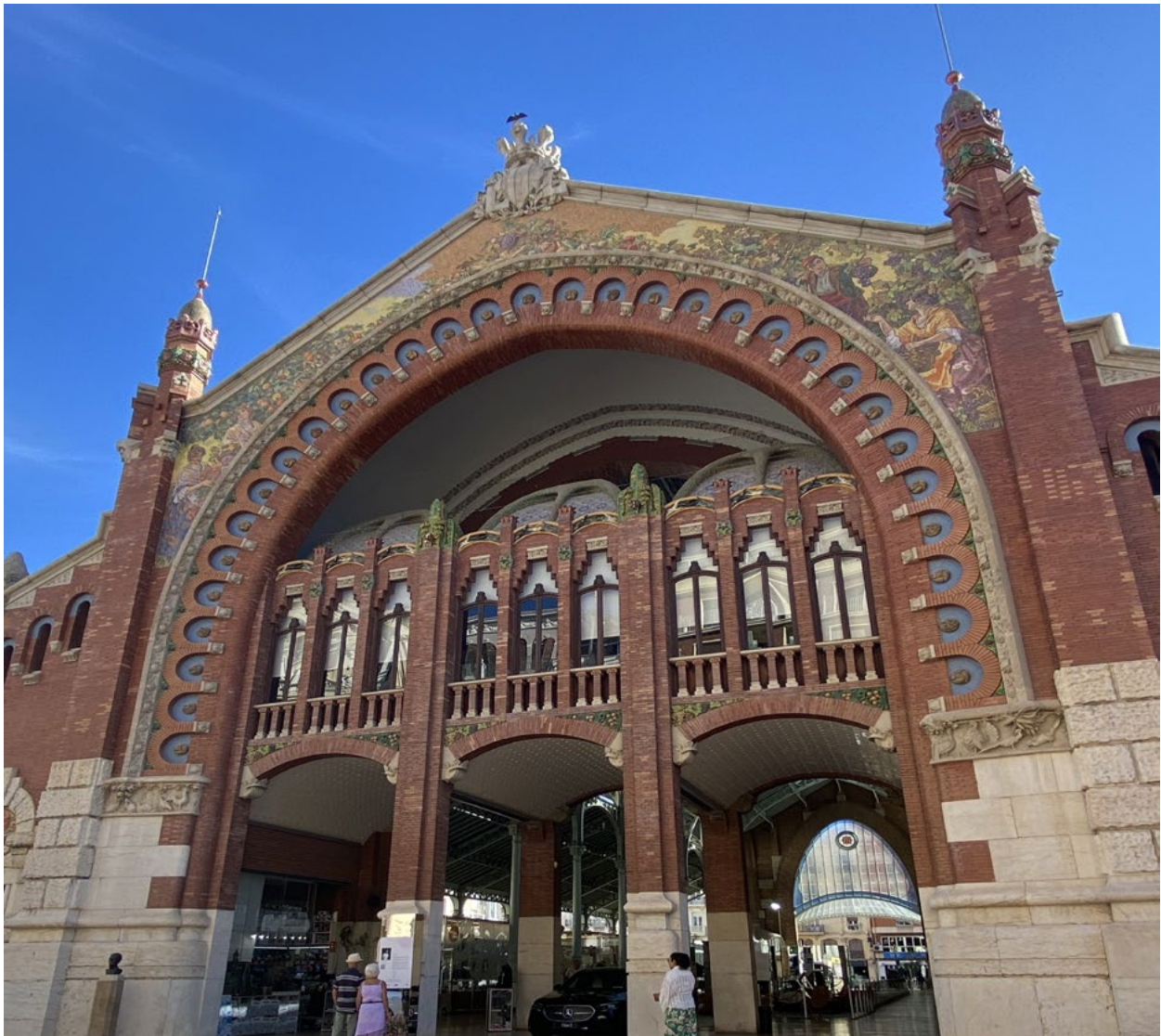
Fig. 3. Valencia, Mercato Colón. Facciata Ovest in via Jorge Juan. (Foto degli autori, 2023)
