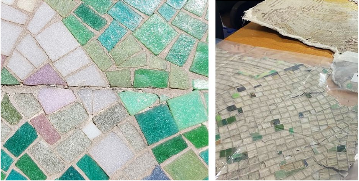
Fig. 3 Napoli, Mosaico di Domenico Spinosa, sede della Facoltà di Architettura di Piazzale Tecchio. A sinistra: dettaglio del rivestimento con tessere di pasta vitrea in cui si evidenzia la giuntura tra due diversi pannelli (foto S. Iaccarino 2023); a destra: campione di pannello strappato poiché quasi totalmente distaccato dal supporto. Su di esso saranno condotte analisi per comprendere la composizione della malta e dei collanti d'allettamento (foto R. Picone, 2022).
