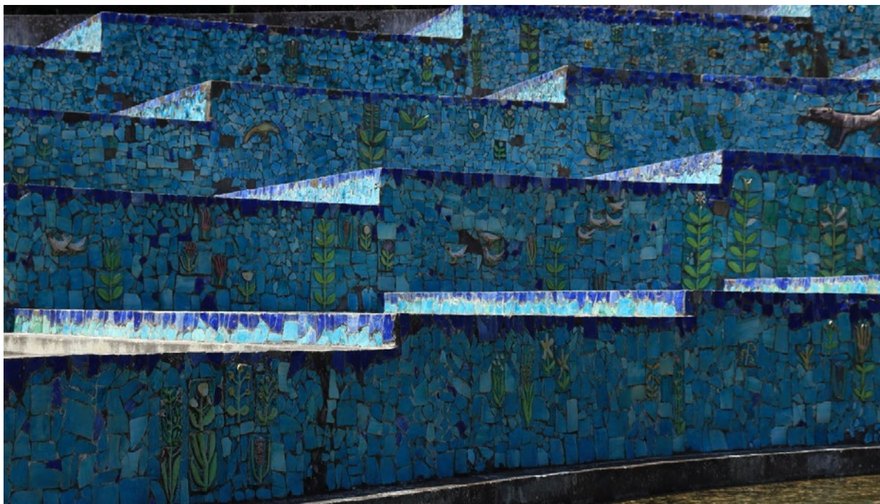
Fig. 2 Napoli, Fontana dell'Esdra, Mostra d'Oltremare. Dettaglio del rivestimento ceramico soggetto a problematiche relative al contatto con l'acqua (foto S. Iaccarino 2021).
