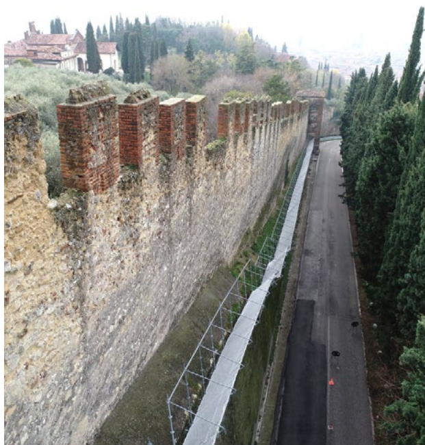
Fig. 2 Lo stato di conservazione attuale delle mura, vista della porzione che costeggia la strada carrabile.
