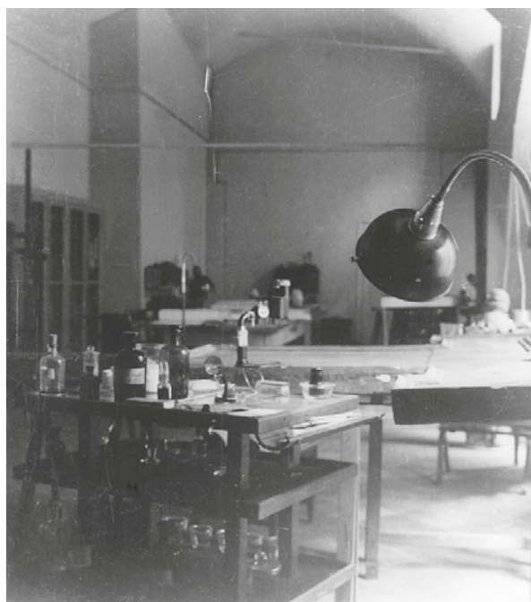
Fig. 3 Firenze, Uffizi, Locali delle Vecchie Poste, Gabinetto dei Restauri , 1934 UNIF-AFR ArchitetM03.
