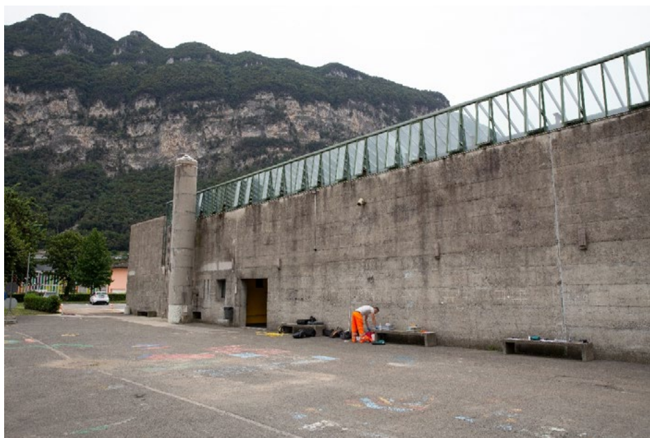
Fig. 1 Facciata Nord della Palestra (© Supsi, 5 settembre 2023).
