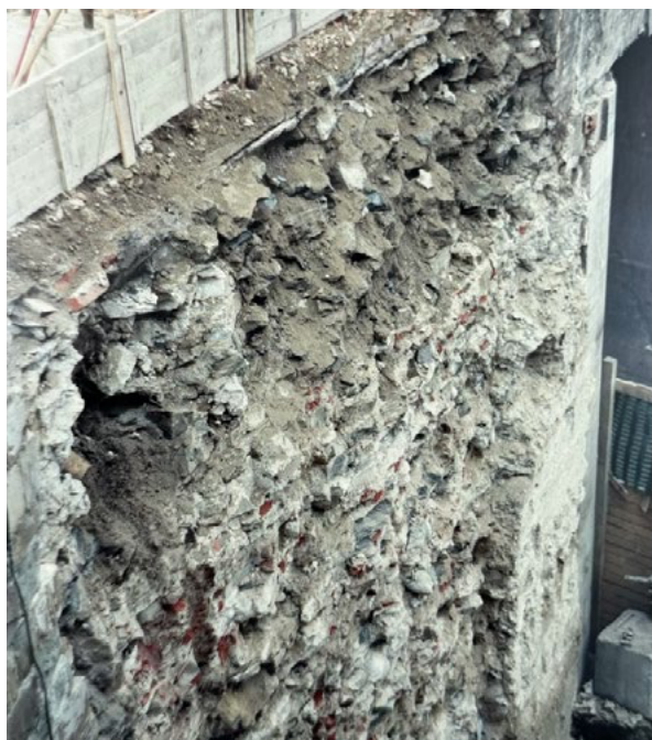
Fig. 6 La spalla del sovrappasso di viale Strozzi realizzato negli anni Trenta del Novecento durante i lavori di realizzazione del nuovo ingresso alla Stazione di Santa Maria Novella, 1989 (Foto ©Impresa Gioacchino Minuto, S.r.l.).
