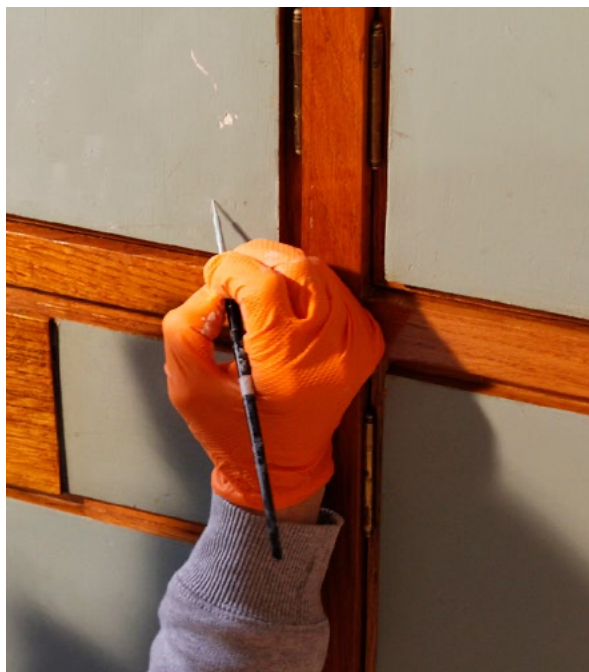
Fig. 4 Padova, Palazzo Bo, Cucina, integrazione pittorica ad un'anta (Foto AR Arte e Restauro s.r.l., 2022).
