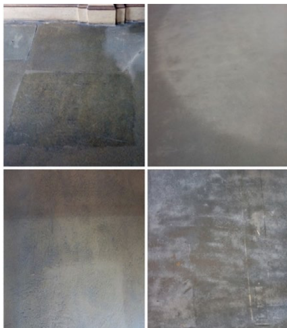
Fig. 1 Castello di Rivoli, atrio juvarriano, Luciano Fabro, opera intitolata Paolo Uccello 1450-1989 , appesa nel 1989. Si notino a terra le tracce di ossidi di ferro accumulatisi nei decenni di esposizione alle intemperie, che ricalcano a terra la proiezione delle geometrie dell'opera (Foto: G. Danesi 2025).
