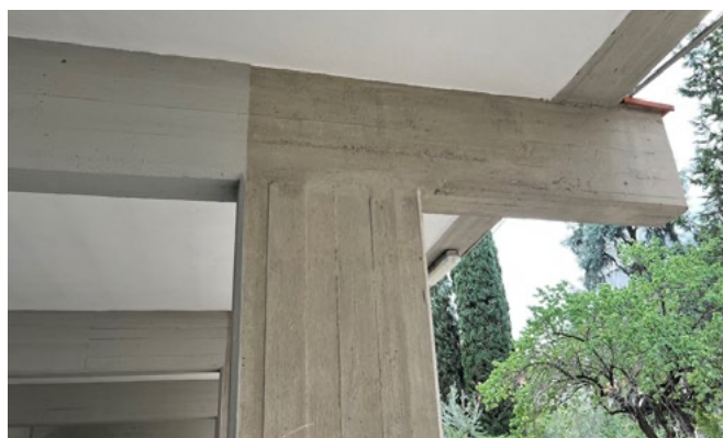
Fig. 3 Differenti colorazioni e finiture tra il paramento originario e l'intervento di restauro. Edificio residenziali a Sorgane, Firenze (foto C. Piferi, 2025).
