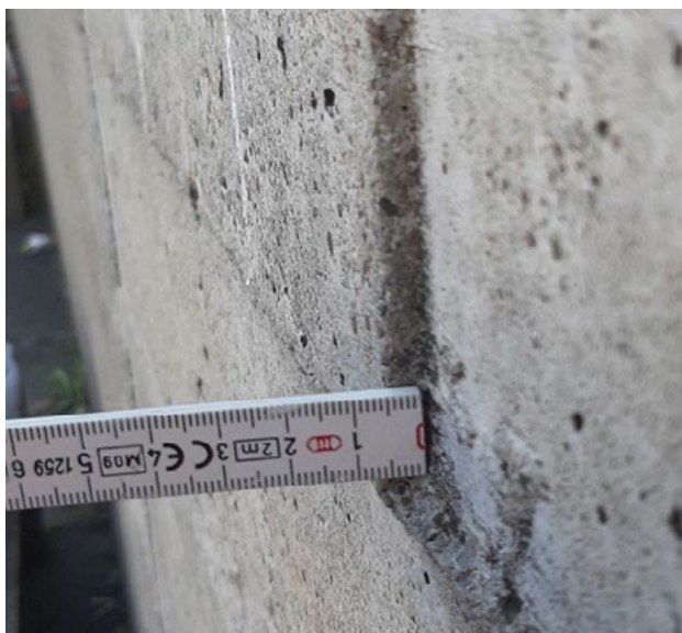
Fig. 2 Dettaglio dei disallineamenti dei casseri che hanno prodotto dei dentelli (© Supsi, 5 settembre 2023).
