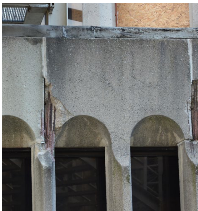
Fig. 3 Firenze, Palazzo degli Affari, 2021. Aree degradate di una delle facciate con fenomeni di espulsione del copriferro.
