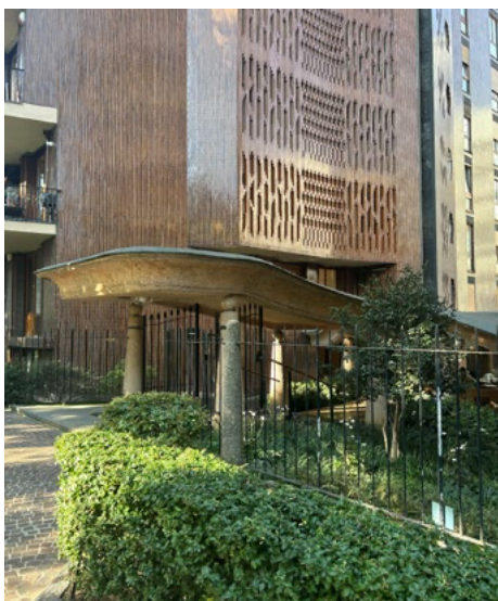
Fig. 1 Pensilina in cemento e graniglia colorato in pasta (L. Magri, 2025).
