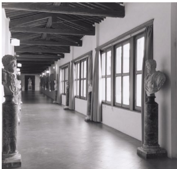
Fig. 4 Firenze, Corridoio Vasariano, interno sul tratto di Ponte Vecchio dopo la rimozione del soffitto intonacato (1991) © Fototeca Kunsthistorisches Institut in Florenz - Max-Planck-Institut, fotografo: Ralph Lieberman, per gentile concessione delle Special Collections, Fine Arts Library, Harvard University.
