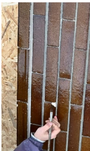
Fig. 6 Integrazione pittorica del rivestimento ceramico id facciata (Archivio Belluschi s.r.l.).
