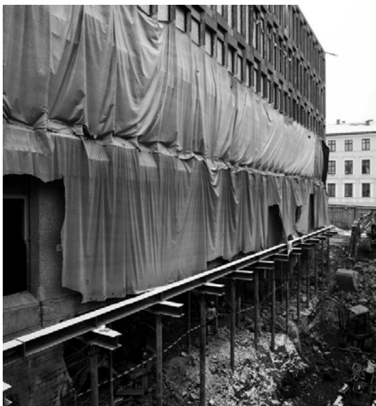
Fig. 3. Oslo, centro Ambassaden. Particolare dello scavo in corso di realizzazione per la sistemazione dei nuovi livelli interrati, © Atelier Oslo.
