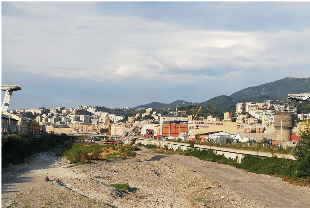
Fig. 2 –Torrente Polcevera, Genova, i resti del Ponte Morandi (foto F. Mazzino)
