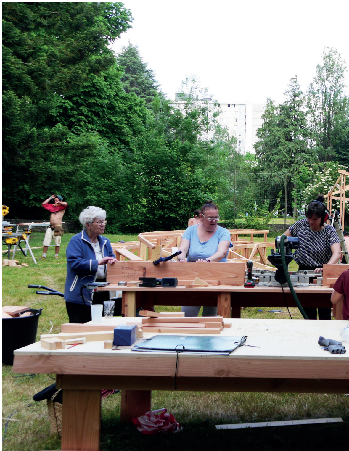
Fig. 11 – Bruit du Frigo, Jardin Invisible in fase di realizzazione (©bdf)
