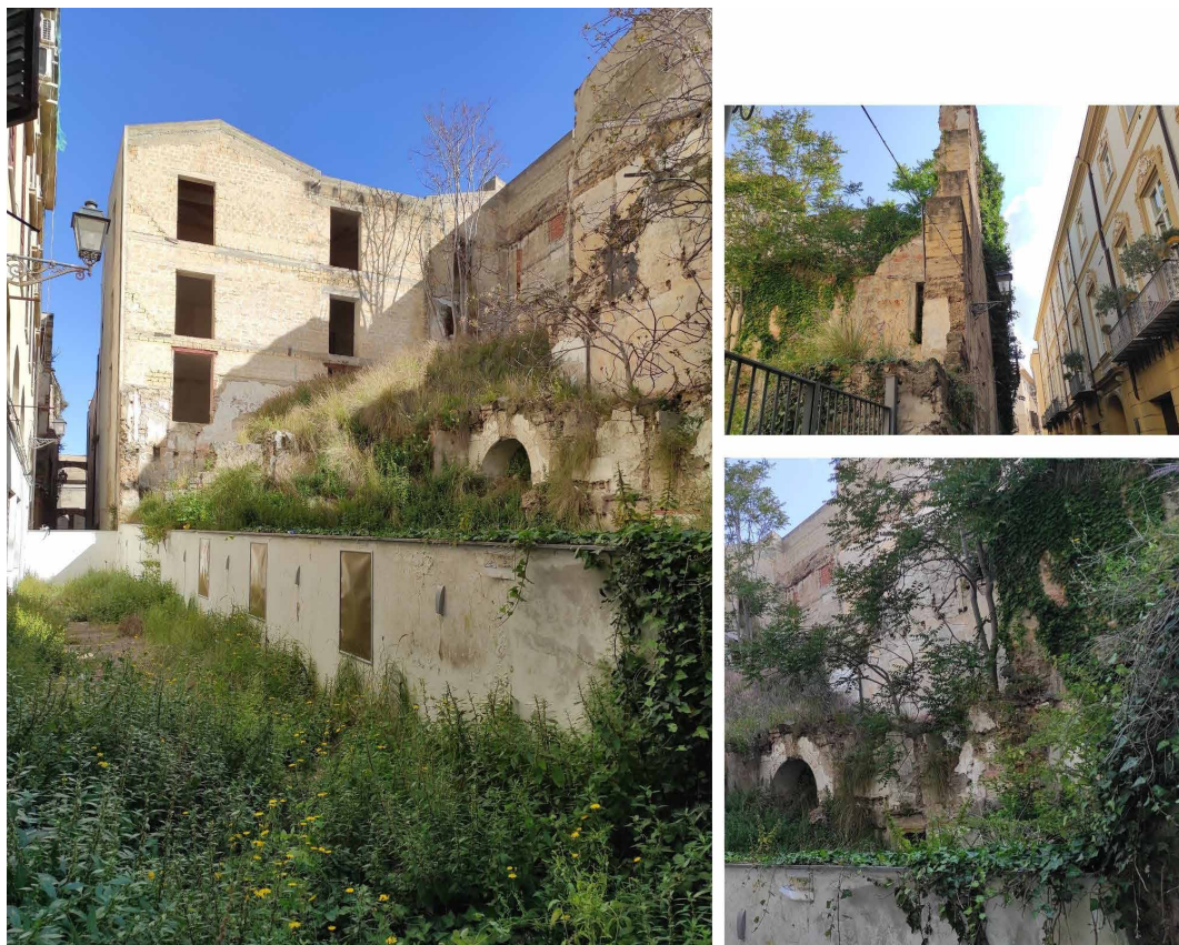
Fig. 4 – Stato attuale dei ruderi di via del Pappagallo (foto: Maria Livia Olivetti, 2022).
