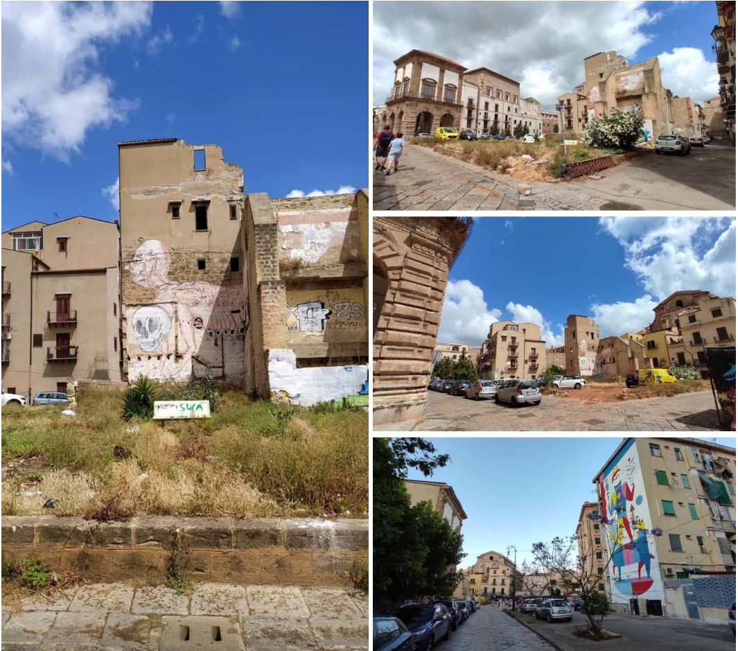
Fig. 5 - Stato attuale dei ruderi e dello spazio aperto di via di Santa Teresa, via dello Spasimo (foto: Maria Livia Olivetti, 2022).
