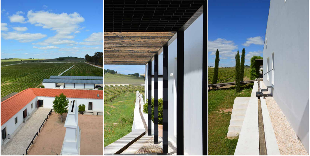
Figg. 8a,b,c – Recupero del complesso di Torre de Palma, ruolo del canale come elemento di articolazione spaziale (Foto: Francesco Marras, 2018).
