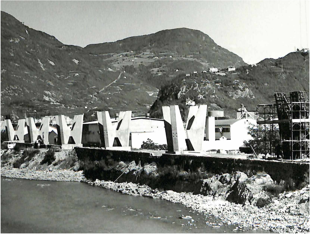
Fig. 1 - Viadotto Bolzano: elevazione pile in corrispondenza di ponte Roma, 1970/74 (Fondazione ing. Lino Gentilini).
