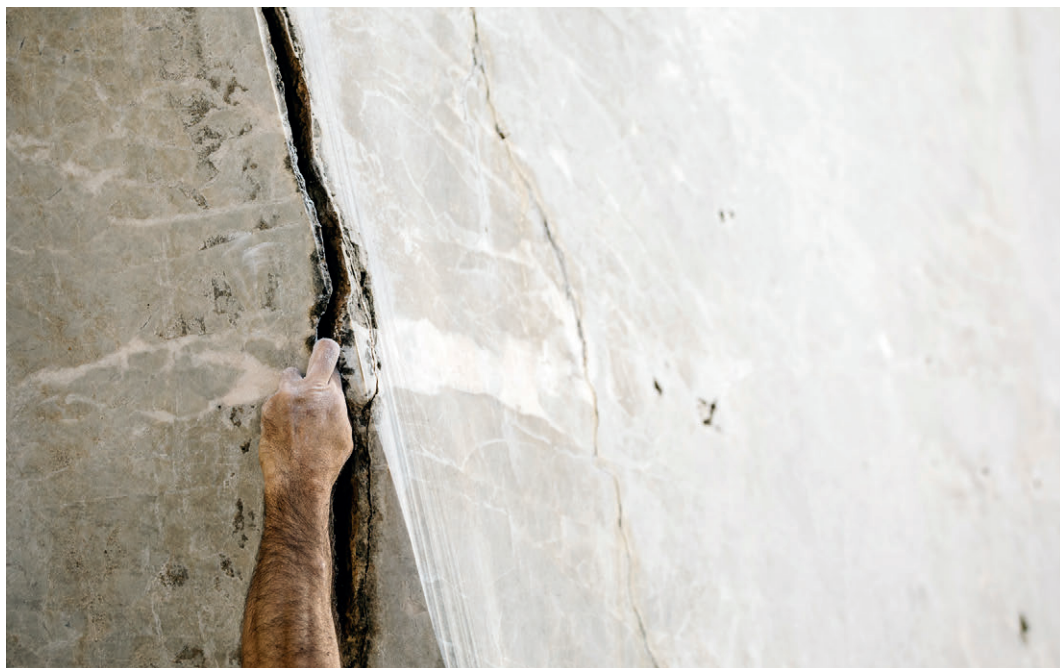
Fig. 6 – Le fessure che si formano naturalmente nella pietra, apparentemente un difetto, diventano invece un appiglio utilizzabile per l'arrampicata (foto: Federico Ravassard).
